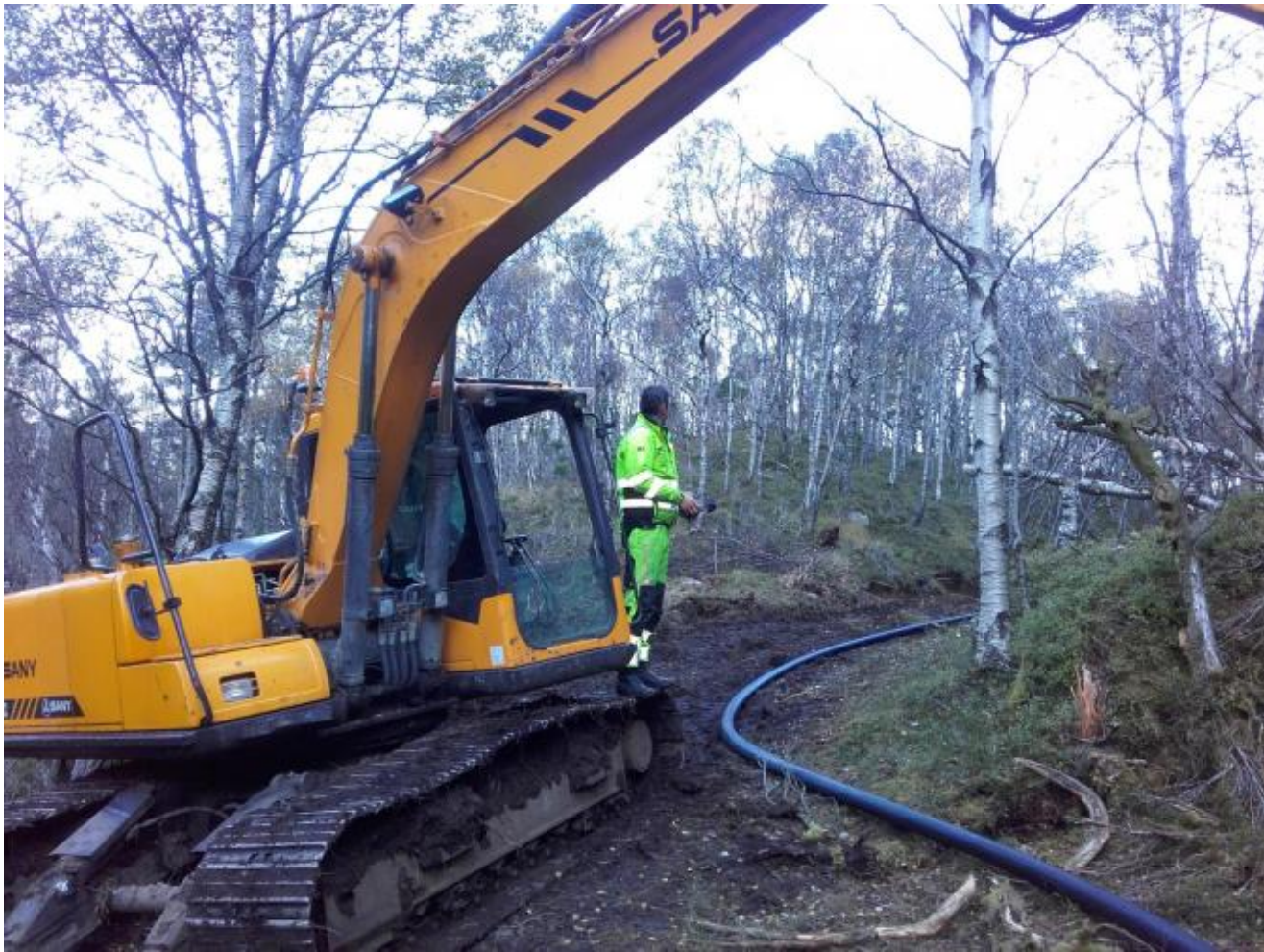
VA-rørleggjar Johannes Kaldestad Feet legg ut og skøyter ledningen.
