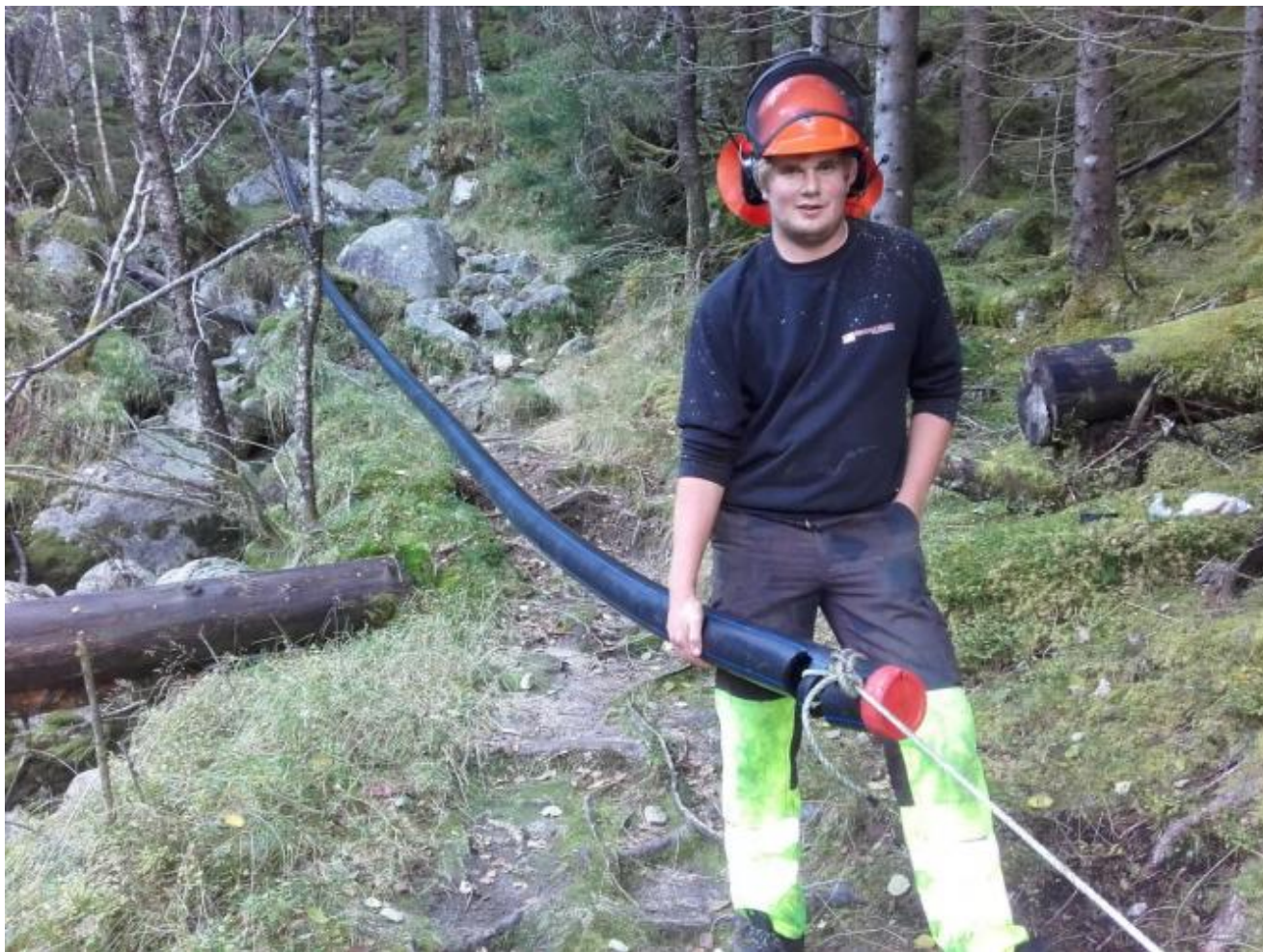
Jone R. Kjærland har vore anleggsarbeidar i Musland Maskin i eit år. Her hjelper han til med utlegging av mellombels vassledning frå Flåtene til Sørstølen.
