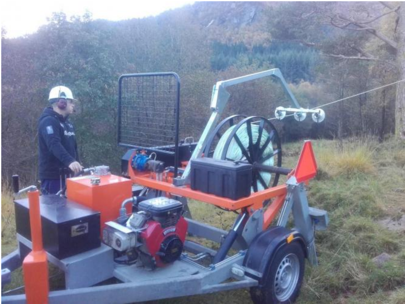
Robert Loven frå Aurland, busett på Sunde, har vore energimontør sidan 1998. Han er fagamann på kabelstrekk og straumførande ledningar frå lågspent til 420 volt.
