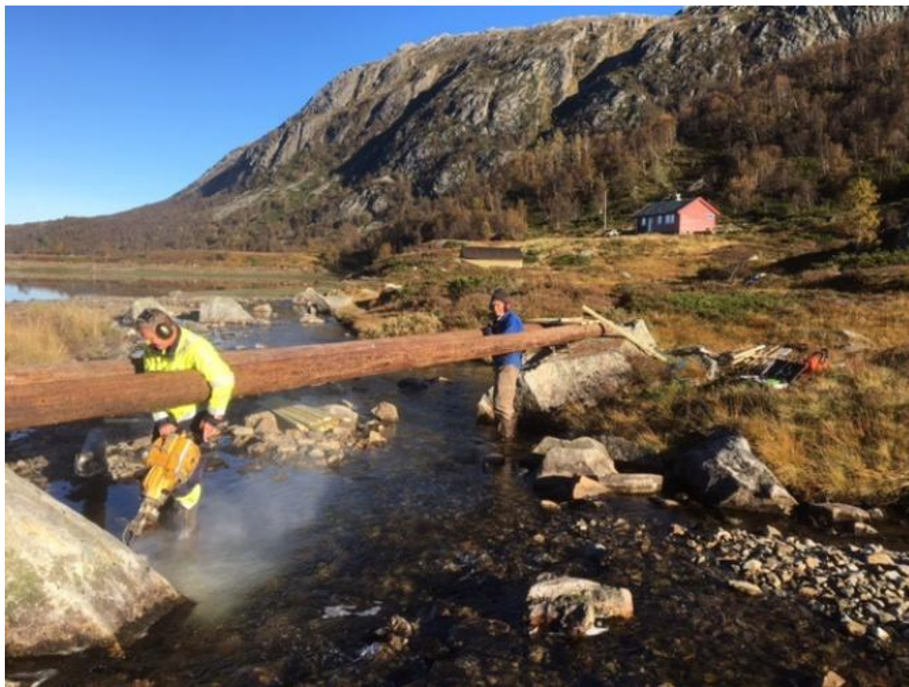
Pål og Svein Ove gjer førebuingssarbeid.
