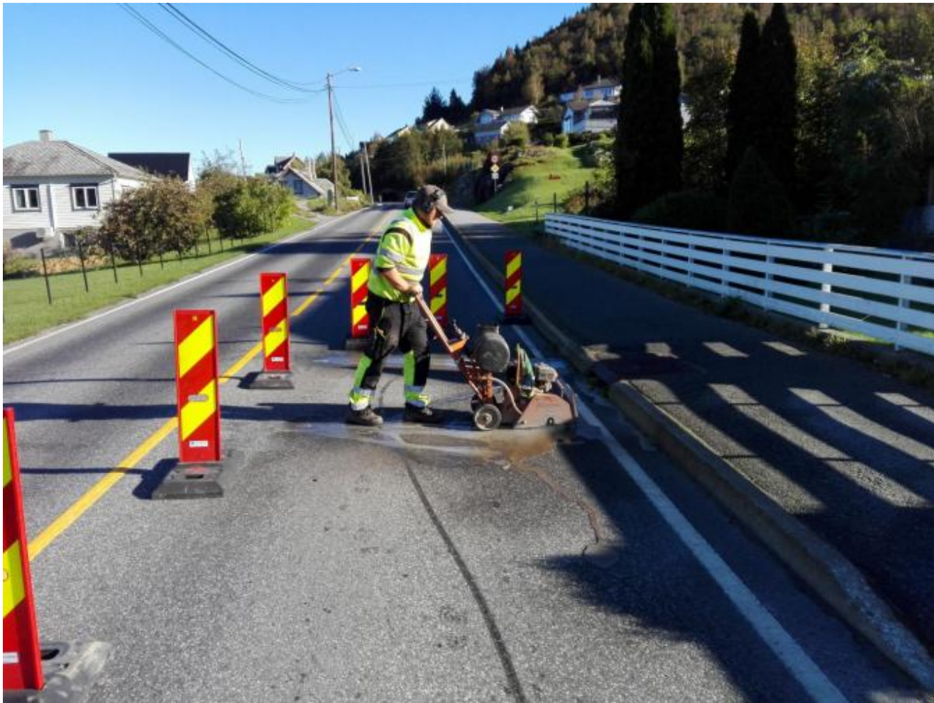
Robert Sundal i gang med reparasjonsarbeidet.
