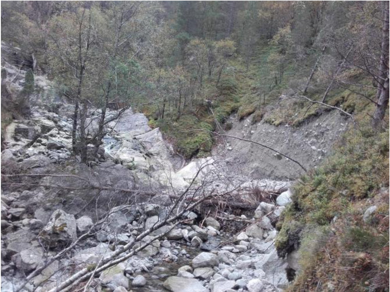
Store erosjonsskader fører til skite vatn i Eikeelva.
