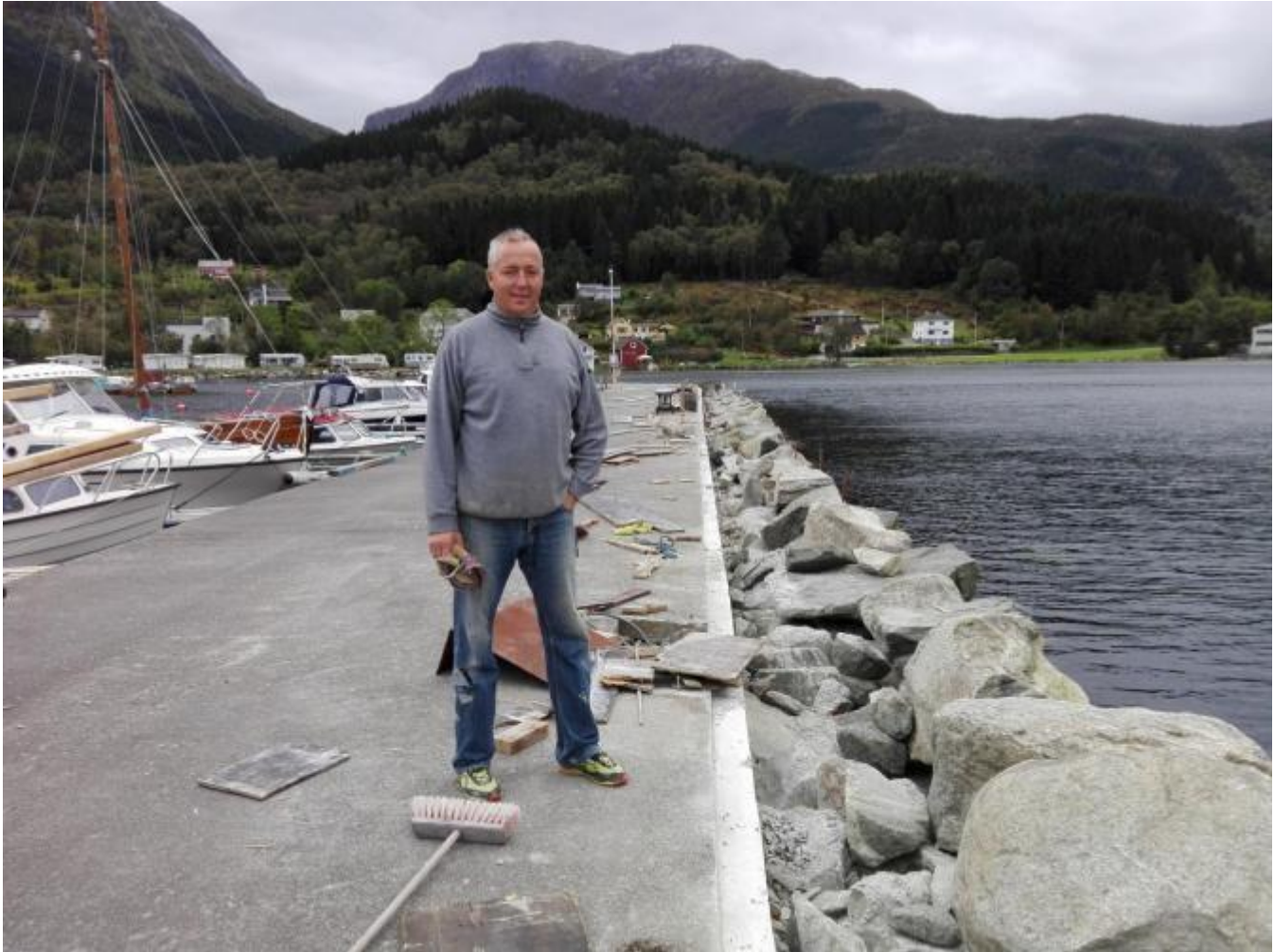
Geir Enes har med god hjelp gjort eit stort reparasjonsarbeid på Øyro Marina.
