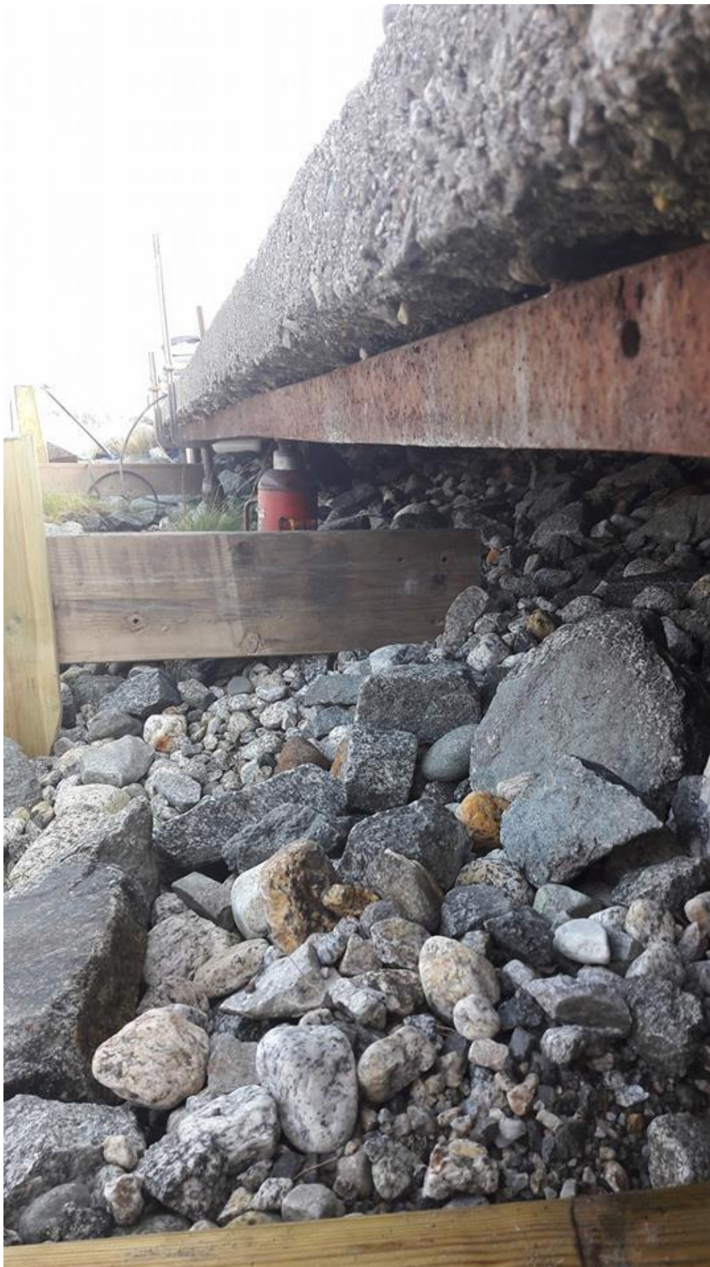
Deler av plata måtte jekkast opp før det vart fylt under og støypt.(Foto: Geir Enes)
