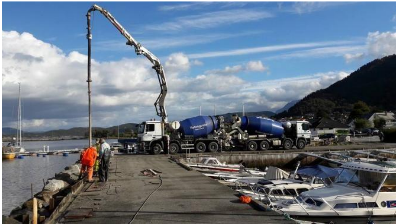
Til no er det brukt 20 kubikk betong, og det vert meir.(Foto: Geir Enes) Tekst
