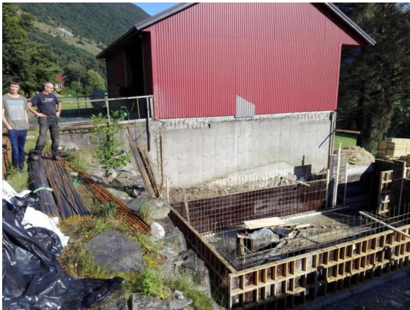
Møkakjellaren er under arbeid, og Anbjørn og Sivert er fornøgde.
