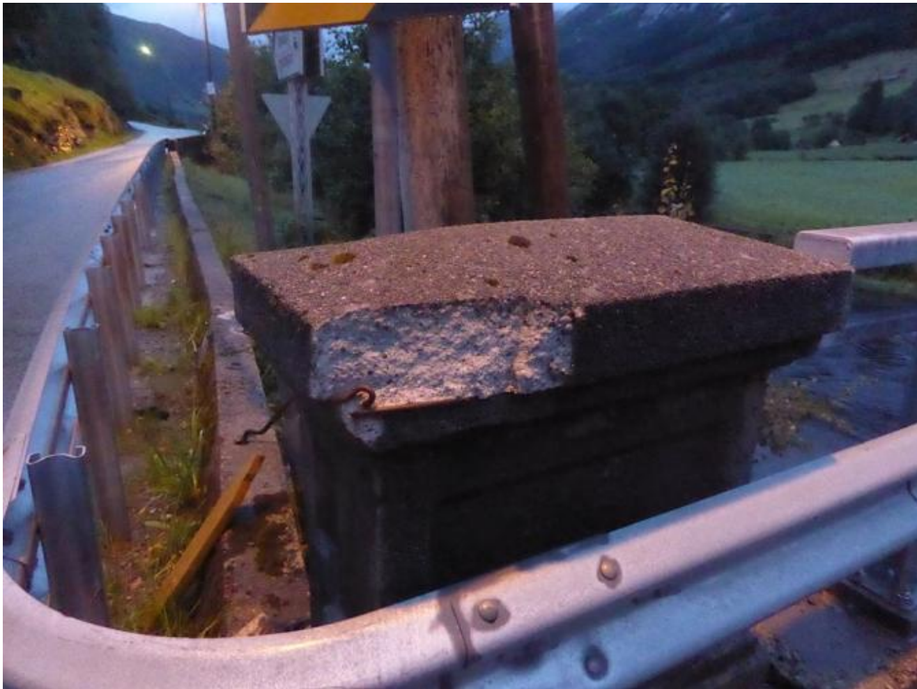
Brua er for trang for store køyretøy, noko denne skaden er prov på.
