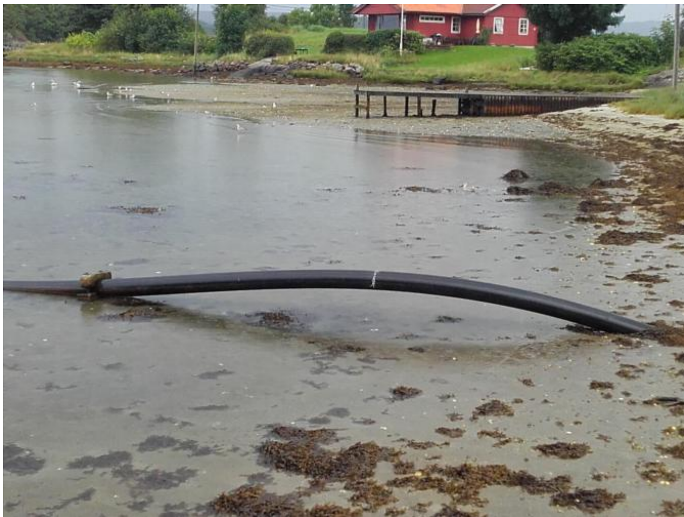
Ein av tre sjøledningar på Stølavikjo ligg i overflata.
