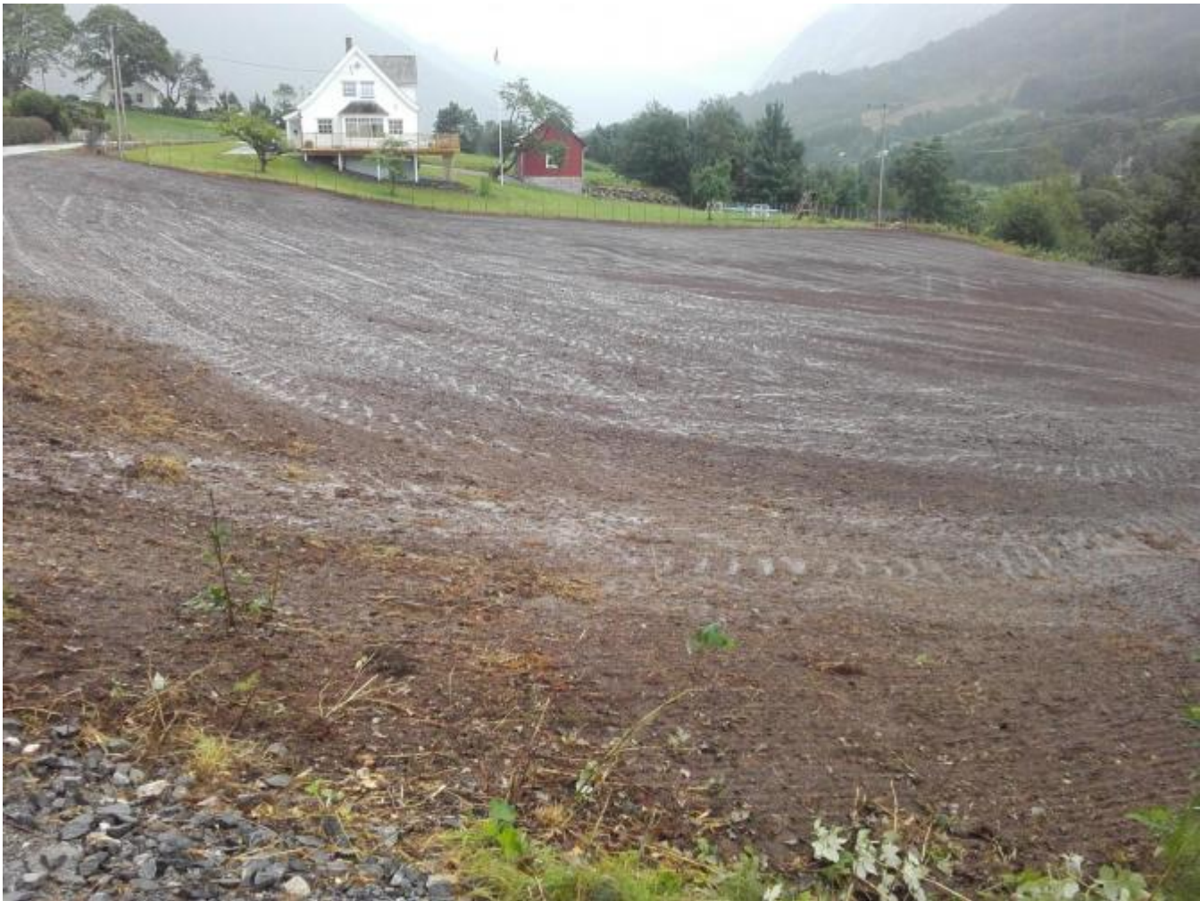
Bakkeplaneringa langs kommunevegen på Dønhaug er ferdig.
