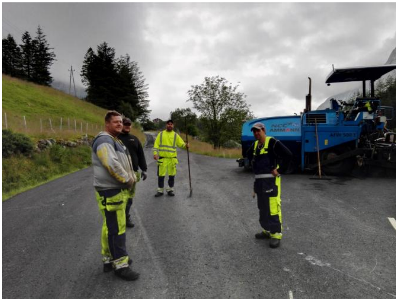
Arbeidarane frå NCC i ferd med å avslutta arbeidet på Øvre Musland i denne omgang.
