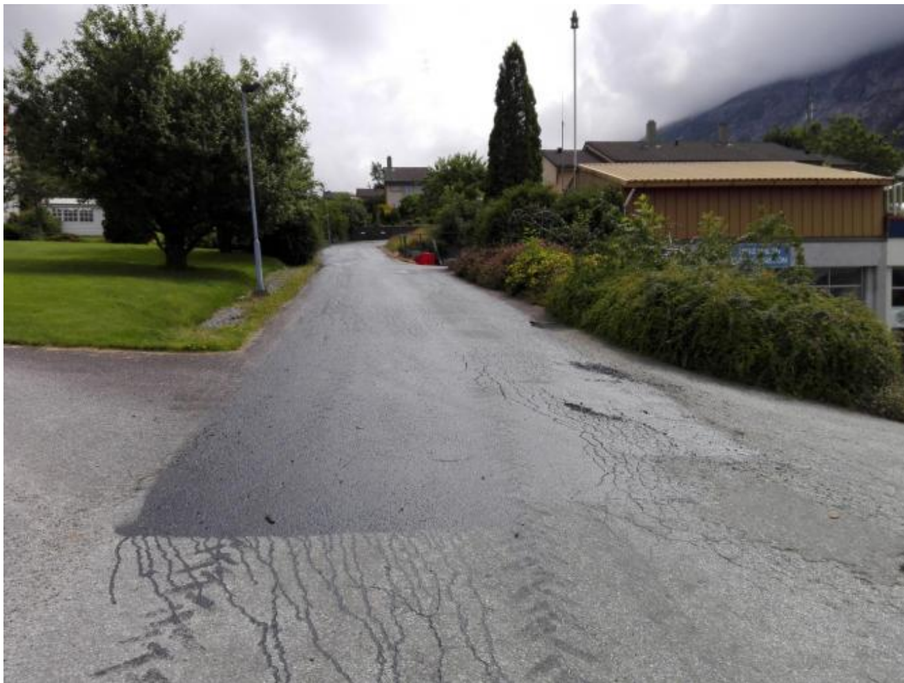
Det skal og koma nytt dekke på denne vegstubben opp til Myro.
