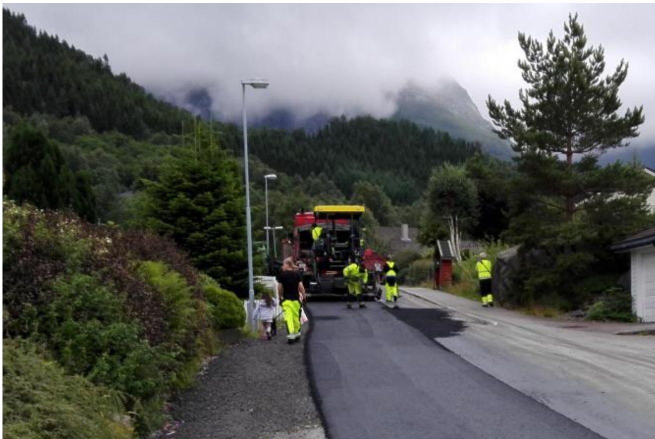
Asfalteringsarbeid i Korsnes.
