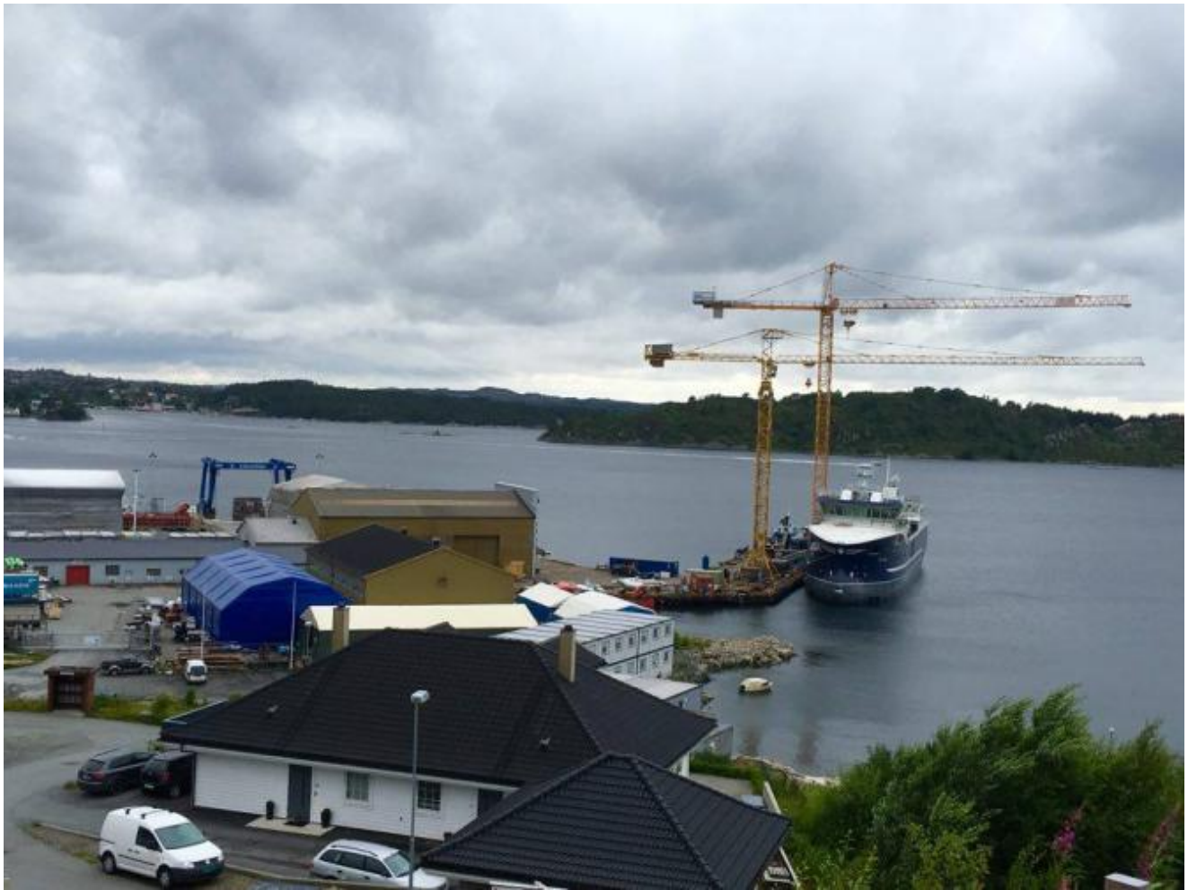
Båten vert no utrusta og klargjort for overlevering ved anlegget på Fitjar.
