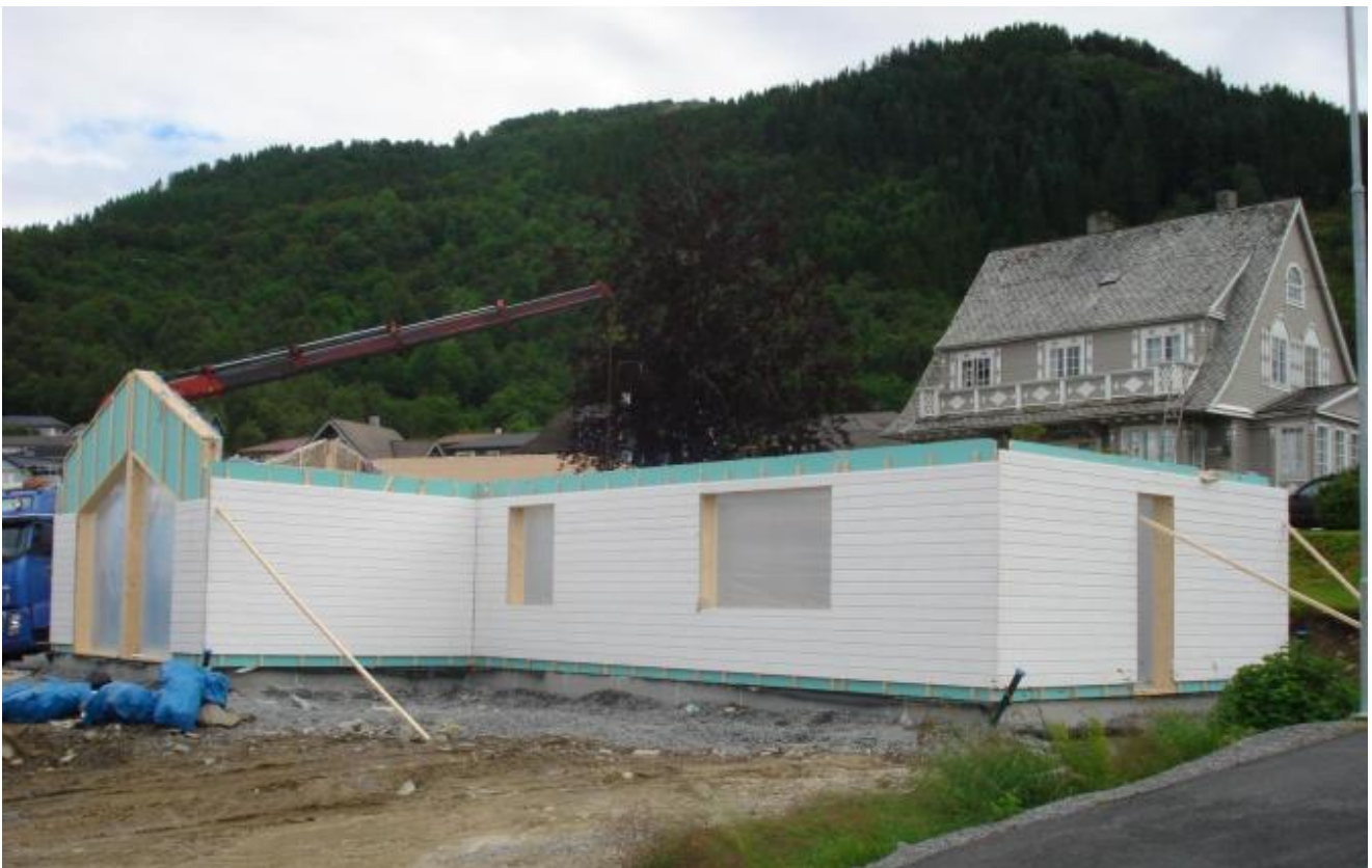
Kl.15 var det bordkleddde vegger rundt heile huset.
