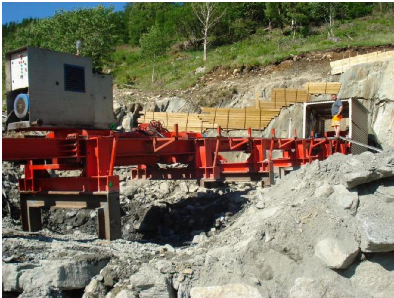
Det er denne store, kraftige riggen som pressar røyra opp gjennom tunnelen.
