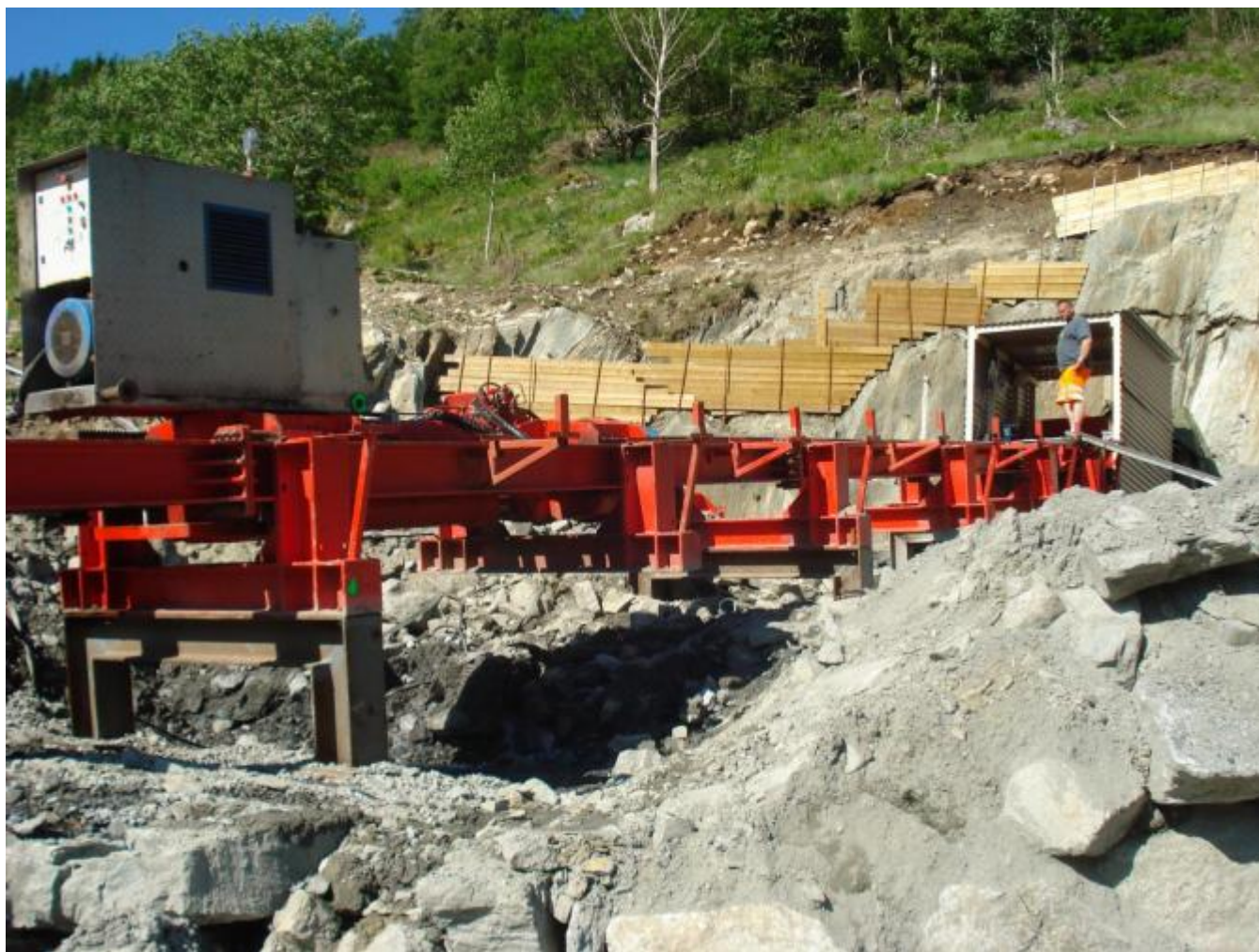
Denne kraftige riggen skal pressa røyra ovanfor opp gjennom tunnelholet
