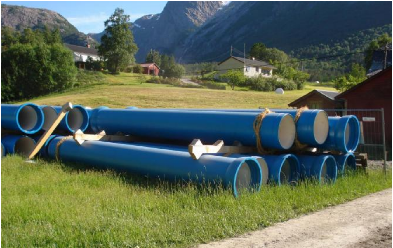
Desse røyr skal gravast ned og føra vatnet vidare ned til kraftstasjonen.
