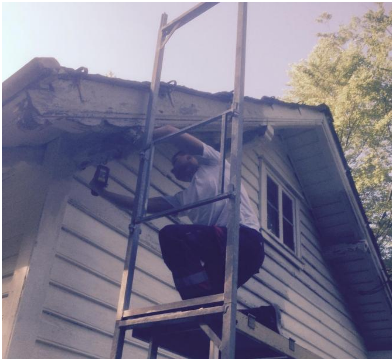
Eirik Ulvenes i ferd med å montera stilas.
