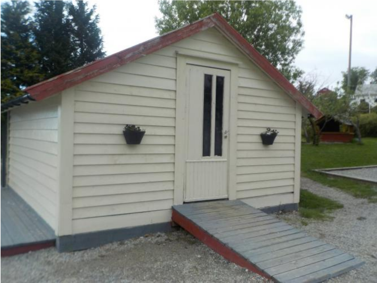
Leikeskuret har fått ny bordkledning.
