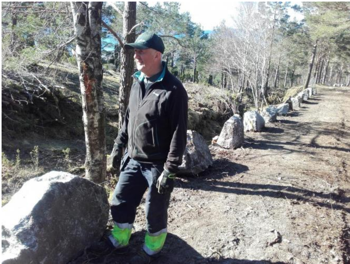
Svein Sætre har rusta opp deler av vegen over Bergsheiane
