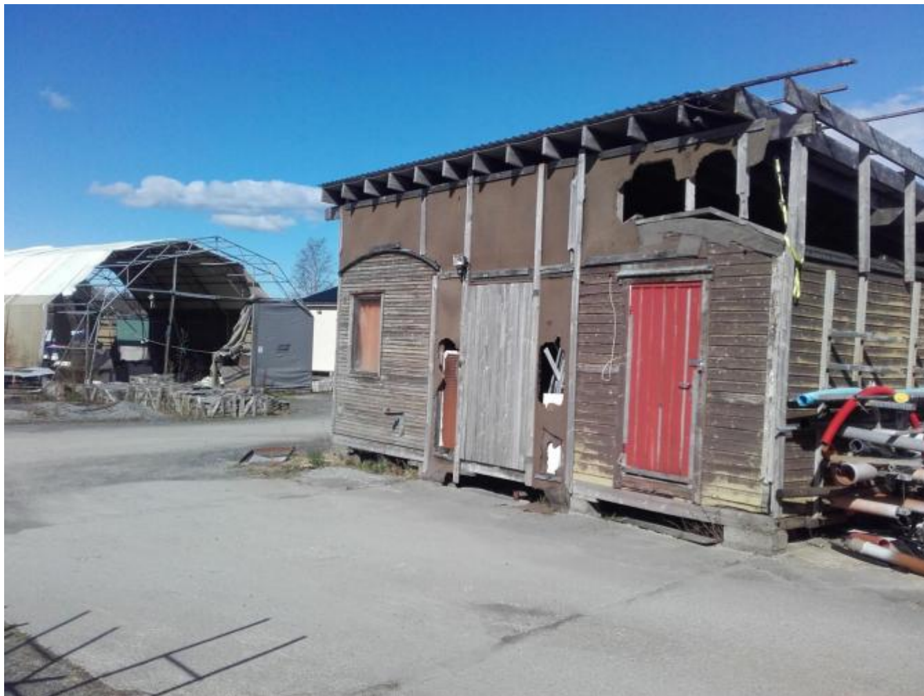
Ein brakkerigg og ein rubbhall utan tak
