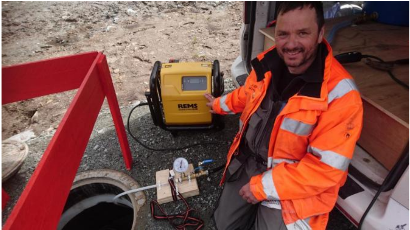
Arvid Hjelmeland under trykktestingsarbeid på Husnes.
