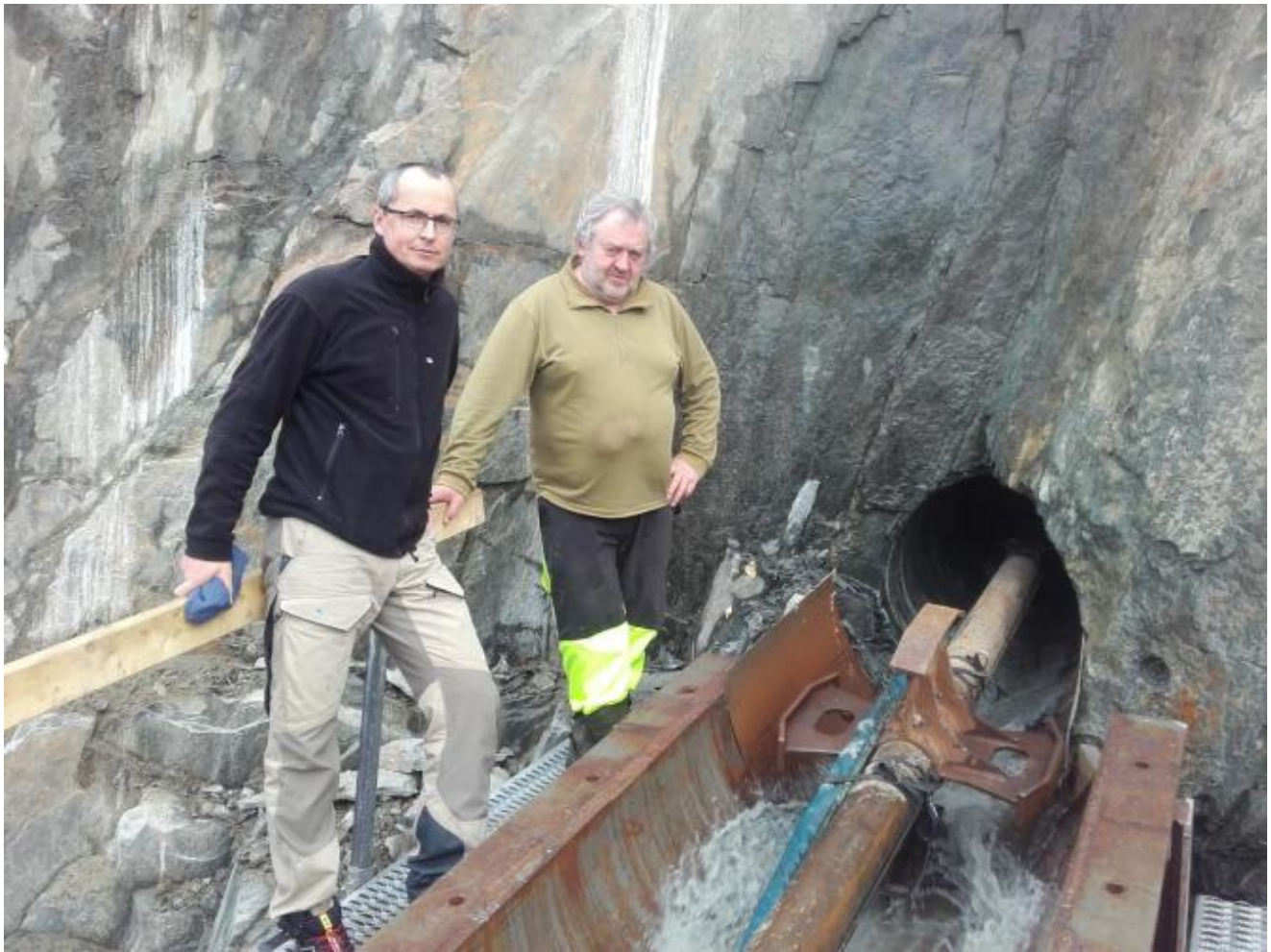
To av grunneigarane, Arne Johannes Haugland og Anbjørn Høivik, ved innslaget 230 m.o.h.
