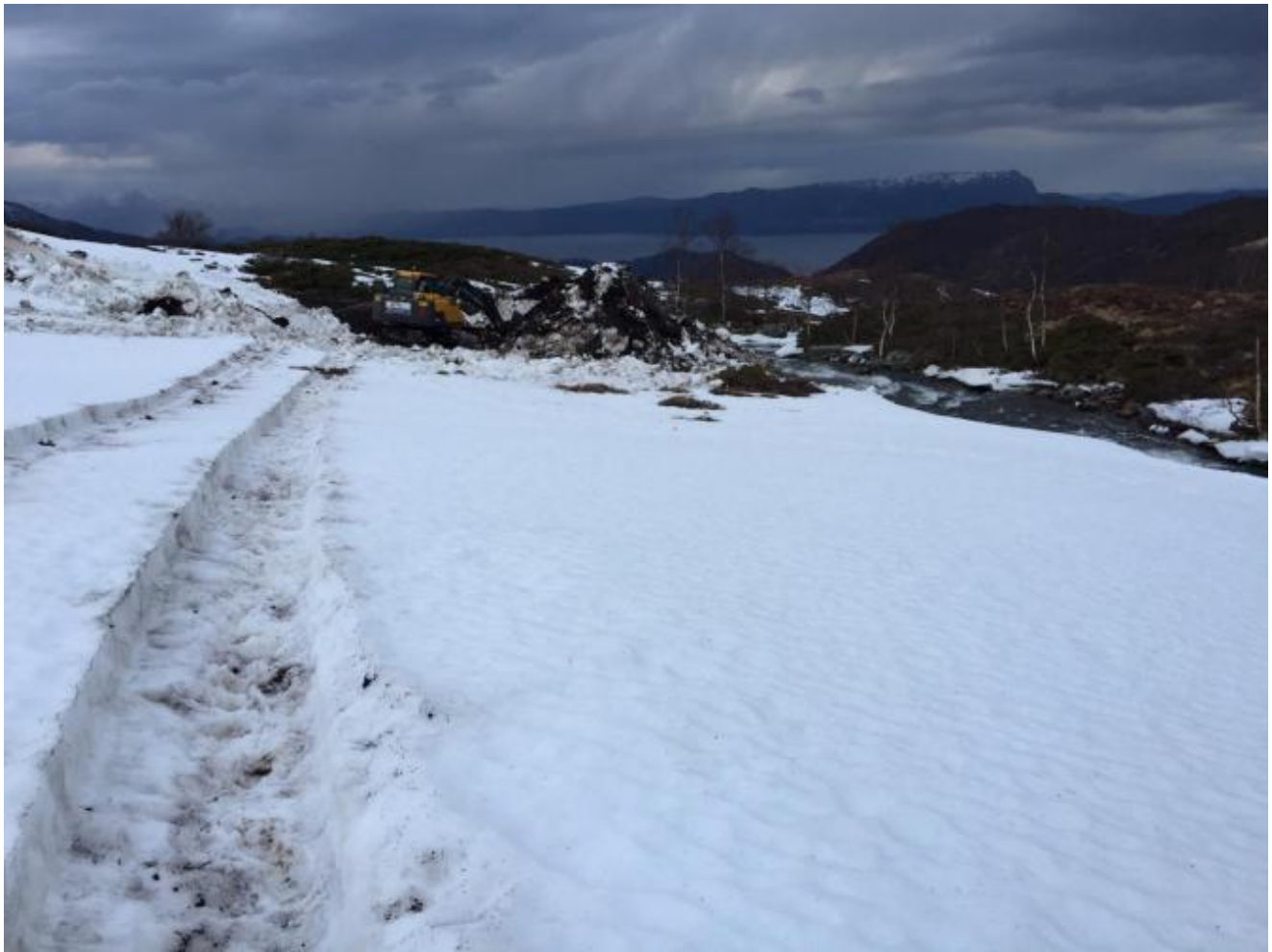
Oversiktsbilete som viser plasseringa av gjennomslagspunktet.
