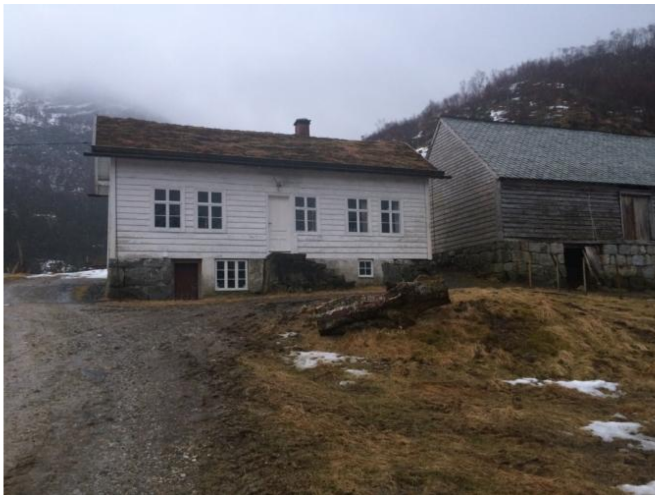
I dette huset på Fjellandsbø vert det kafe på langfredag.
