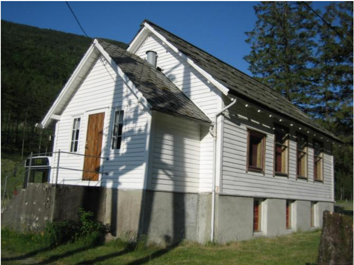
Forsamlingshuset Vonheim med renoverert kjellar, toalett og kjøkken
