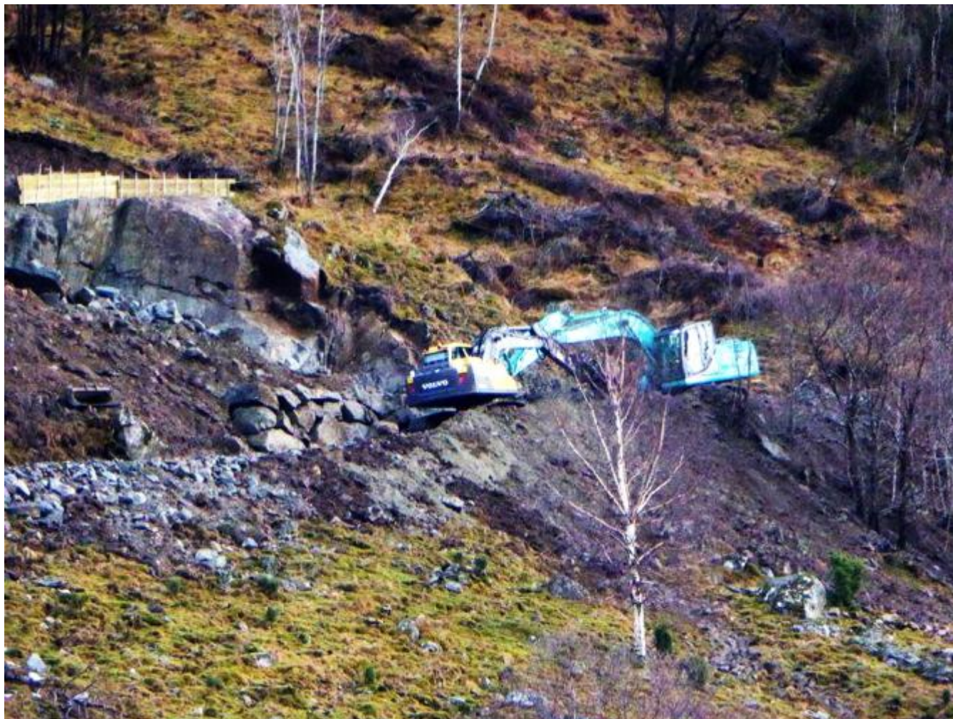
Det er påhogget for tunnelboringa som no er igang
