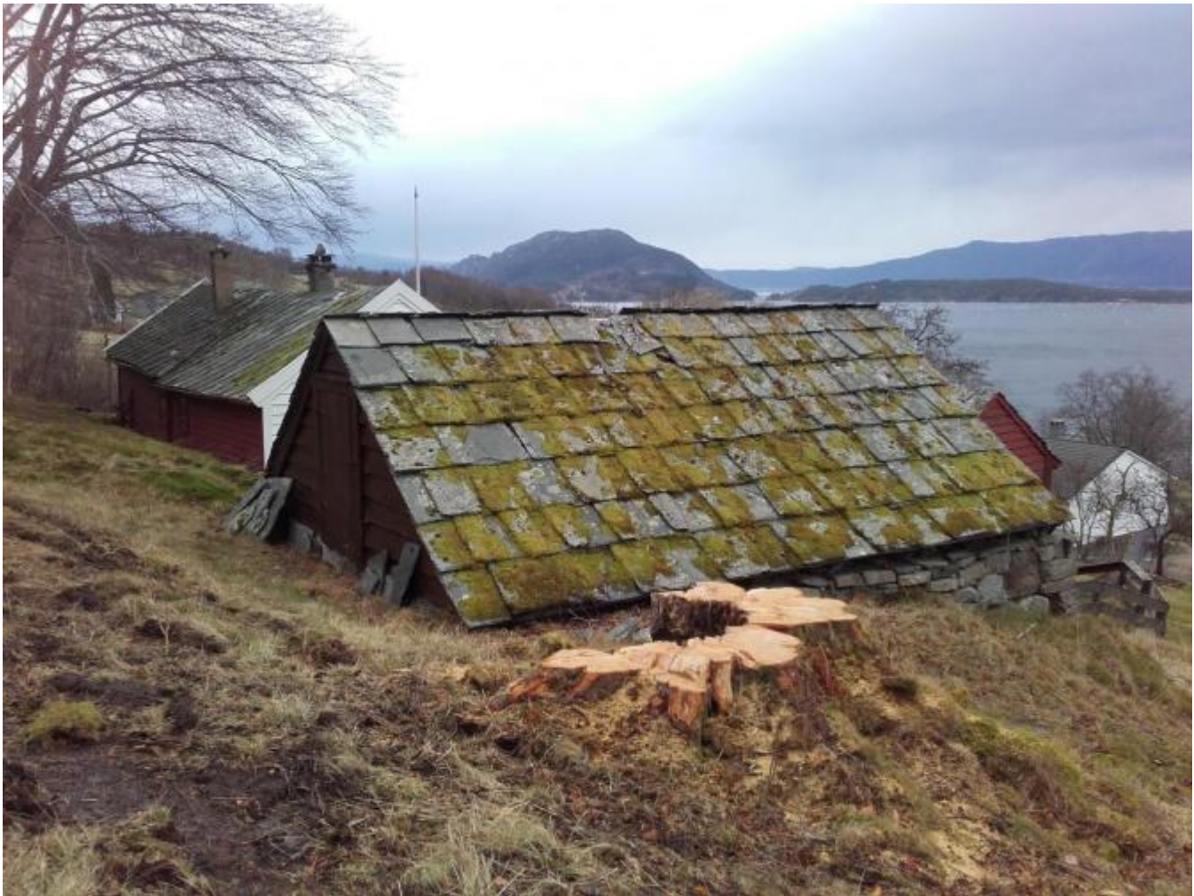
Bygdetunet Rød er rydda etter skaden i haust. Skaden på stallen vert utbetra til våren.
