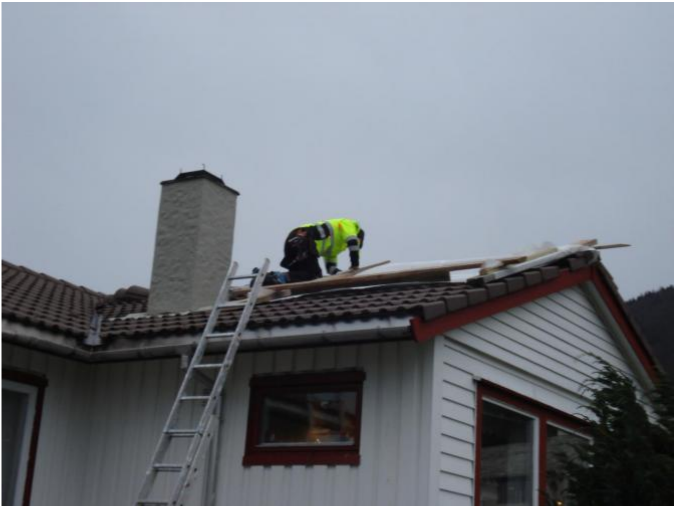
I ferd med å sikra taket etter skadene i Korsnes.
