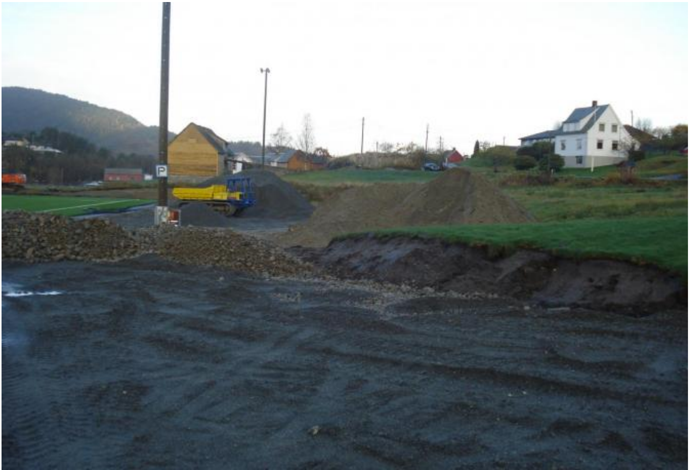
Arbeidet med byggetrinn 2 er godt i gang.
