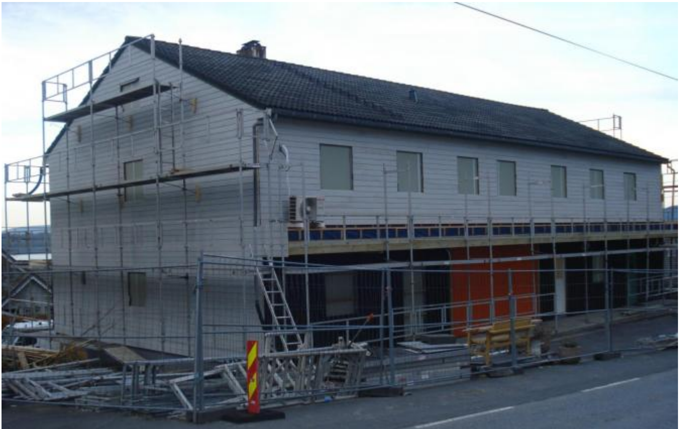
Storarbeid er i gang for å gjera Mollo-bygget om til 6 leiligheter.
