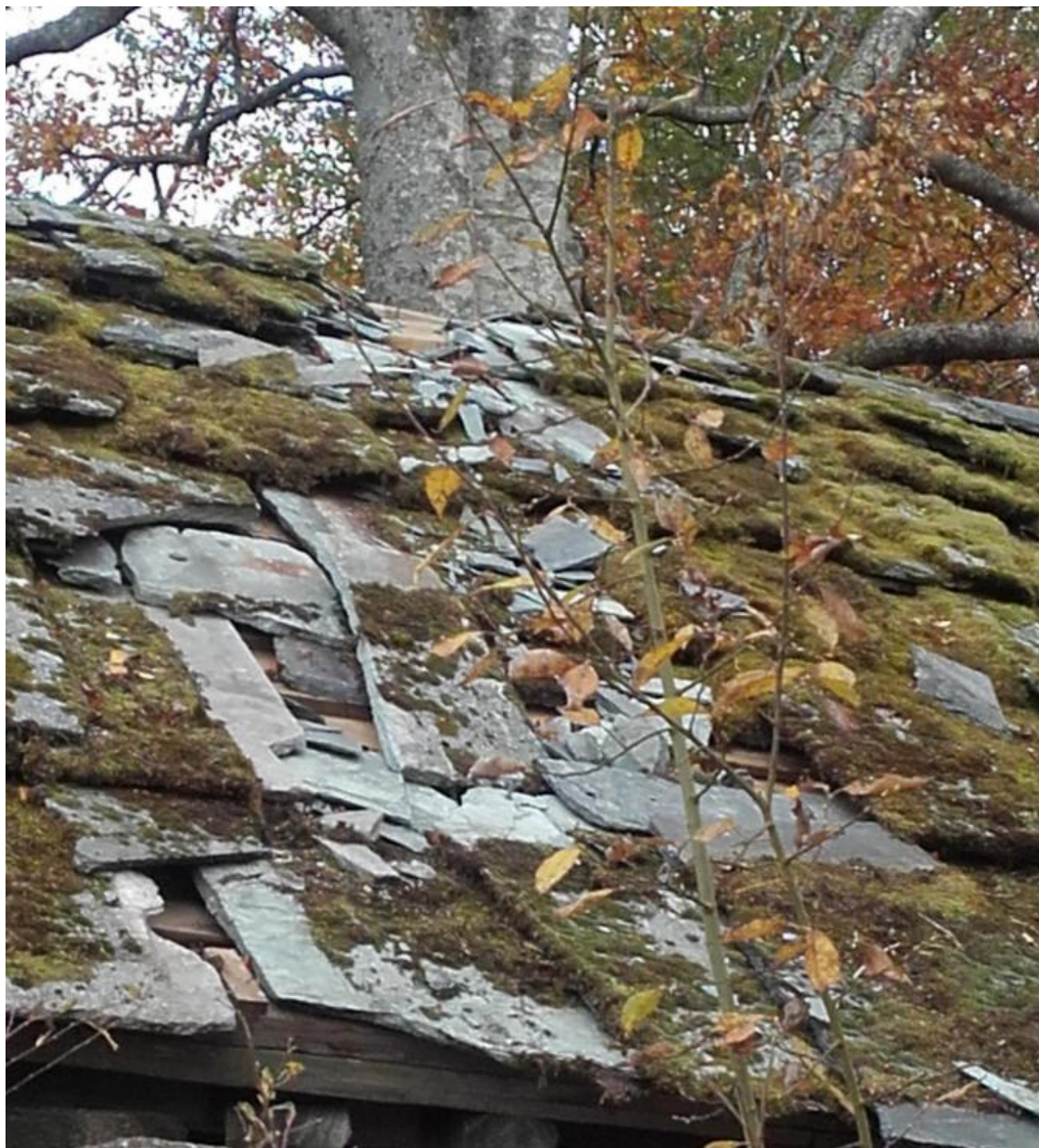
Sterk vind i helga påførte hestestallen skade på taket
