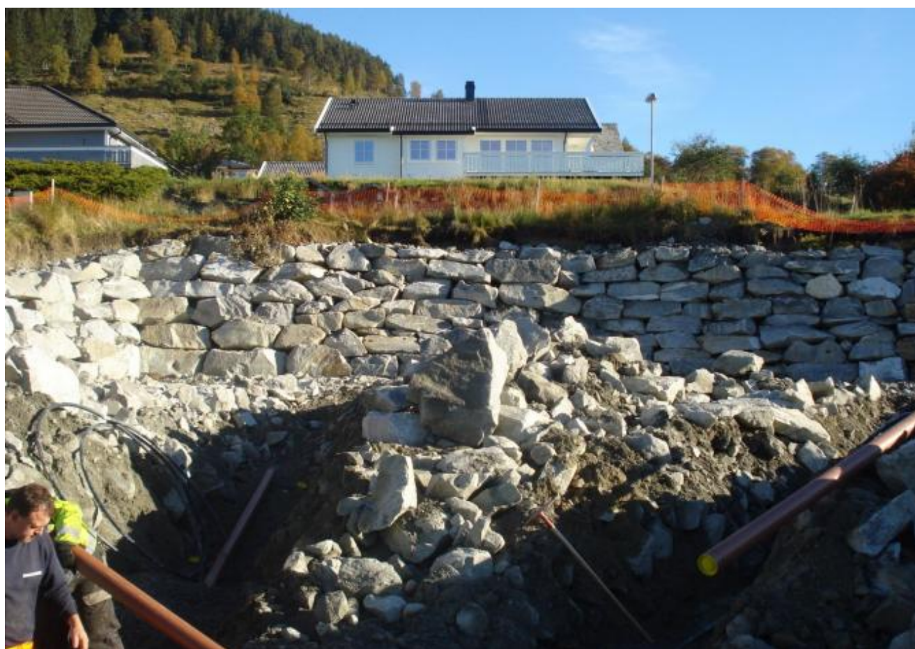
Arbeid med kloakk og vassleidning
