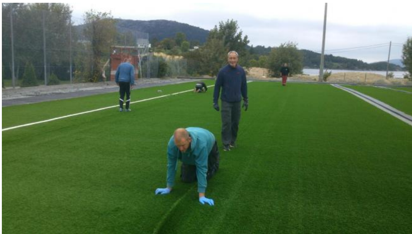
Banen er grøn og fin. Arbeid med skøytane pågår.
