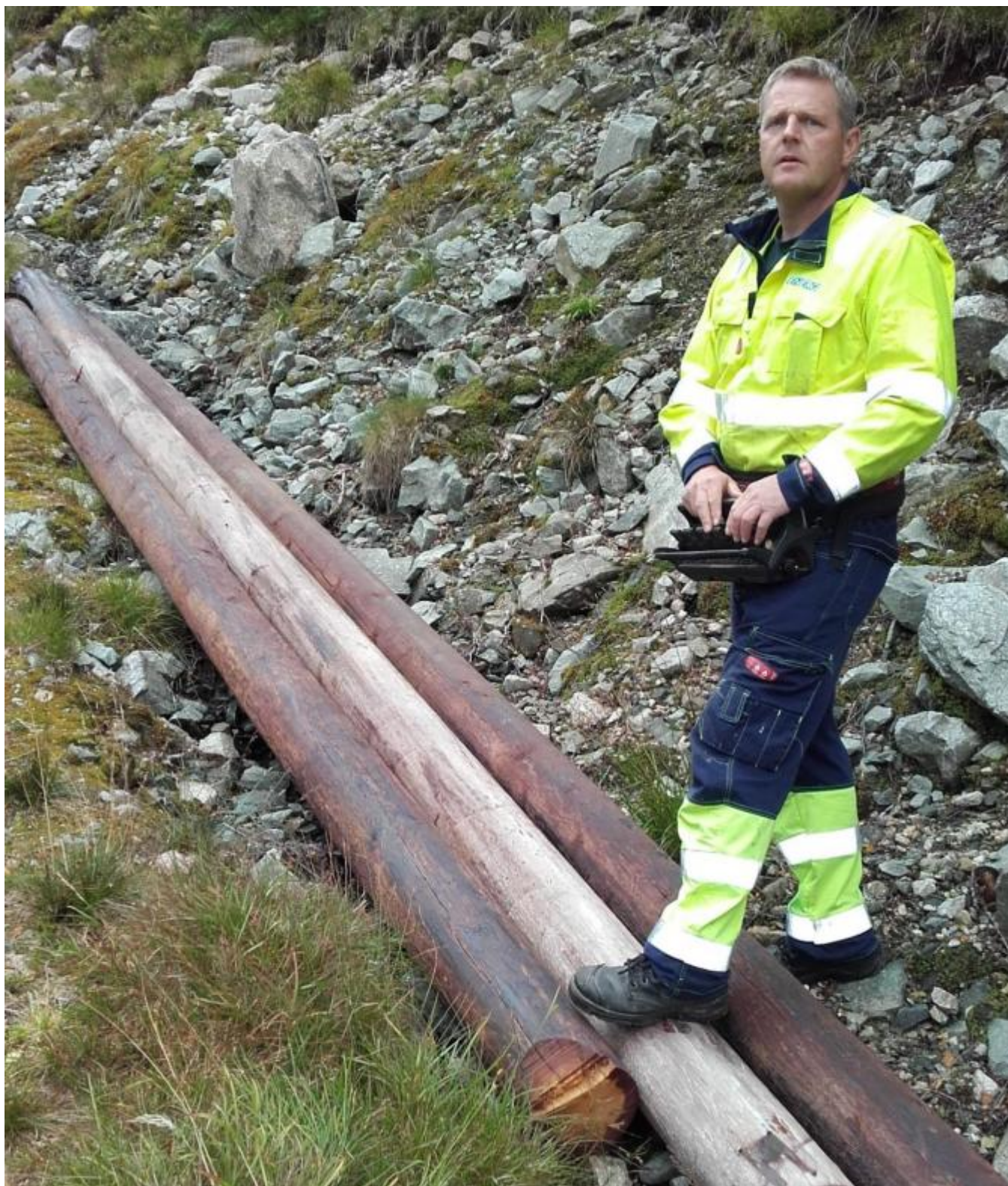
Svein Ove Bråtun hjelper til med transport av fundamentet til brua
