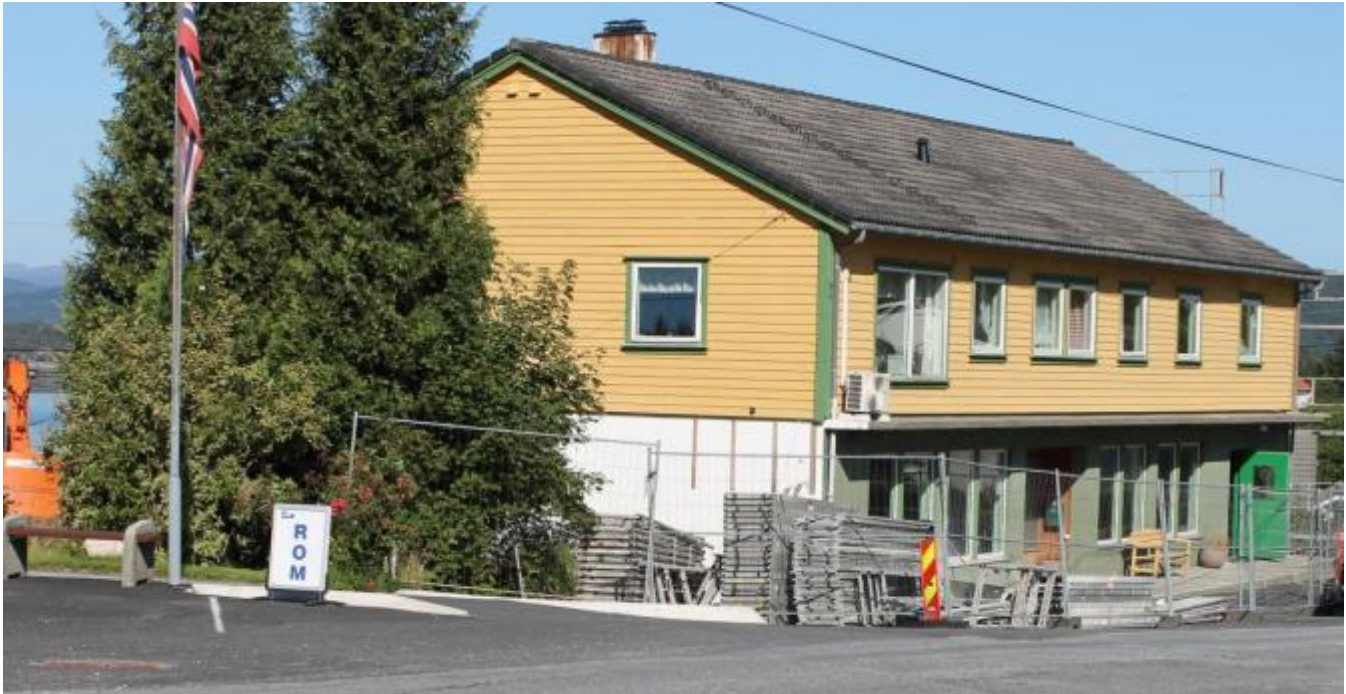
Geir Rusten er godt igang med ombygging til 6 bueiningjar
