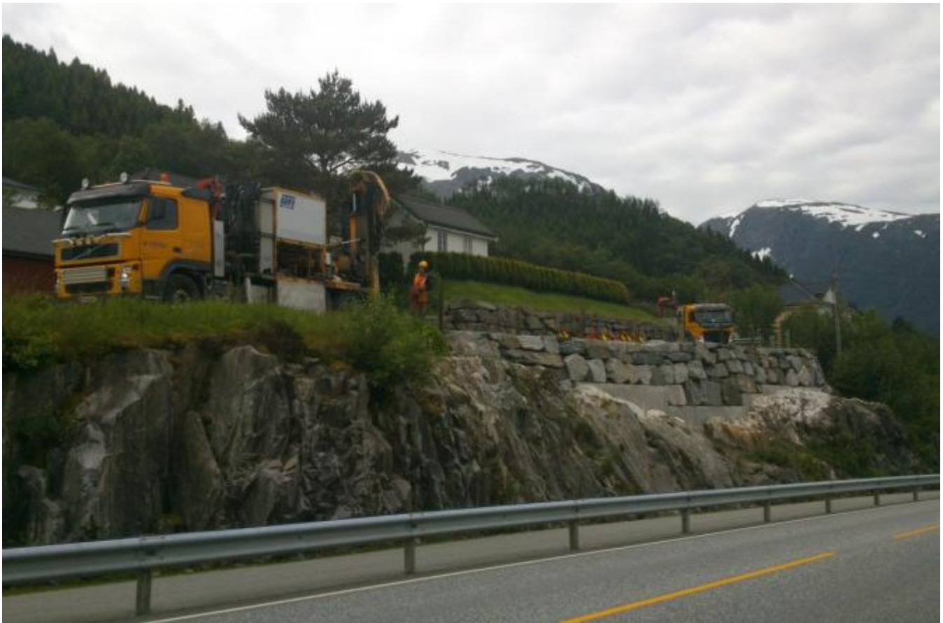
Frå arbeidet der den fremste bilen set ned stolpar medan montering av rekkverksskinna føregår ved den bakre bilen. Tekst, foto og nett: Thor Inge Døssland.
