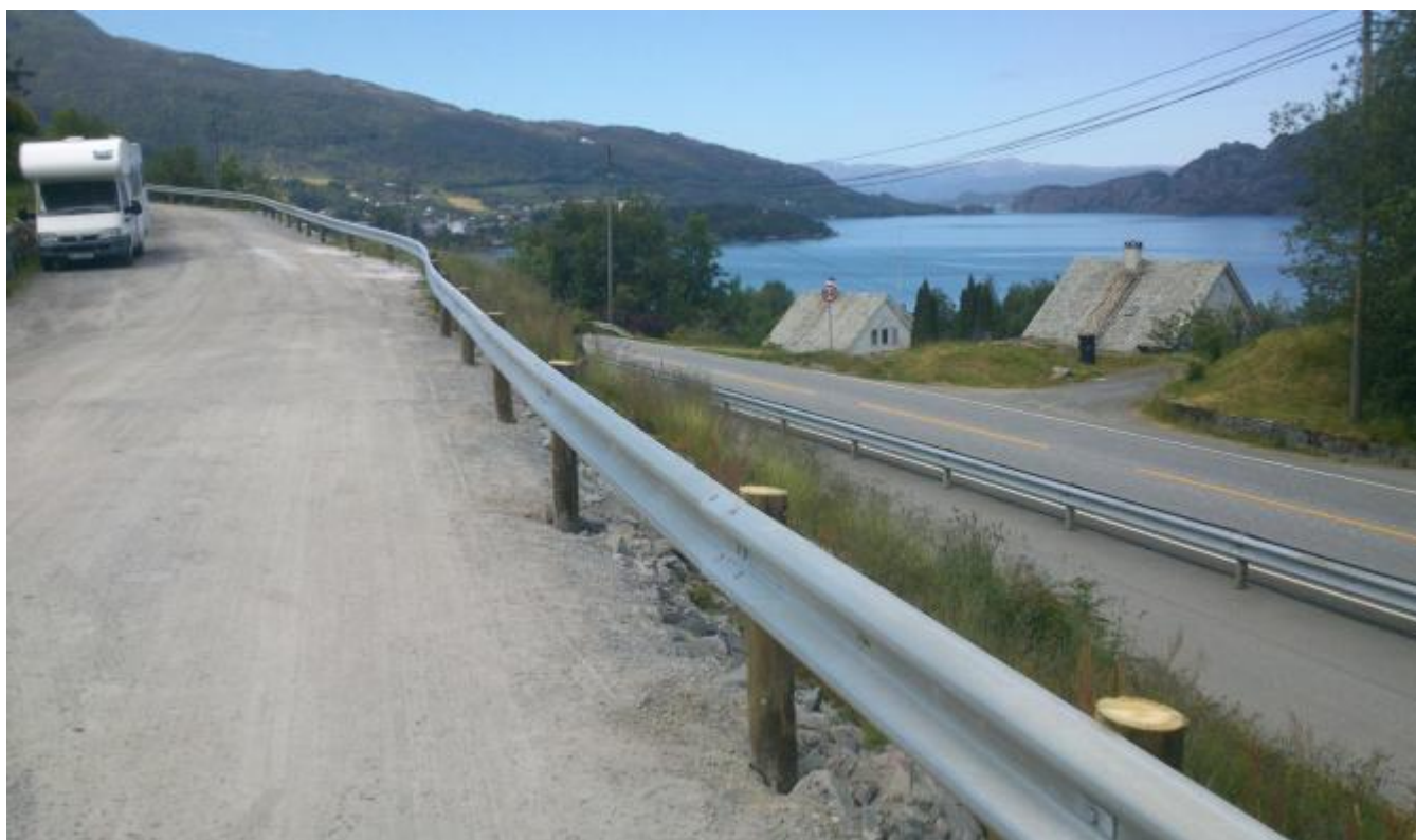
Nytt autovern er på plass i Ospelunden byggefelt.
