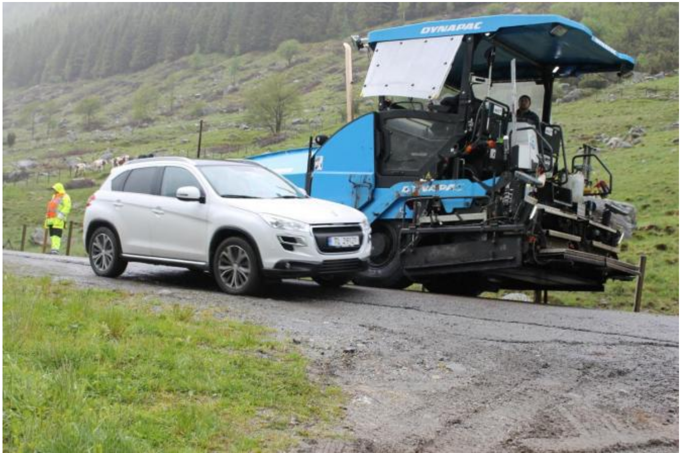
Asfalteringen har gått raskt unna
