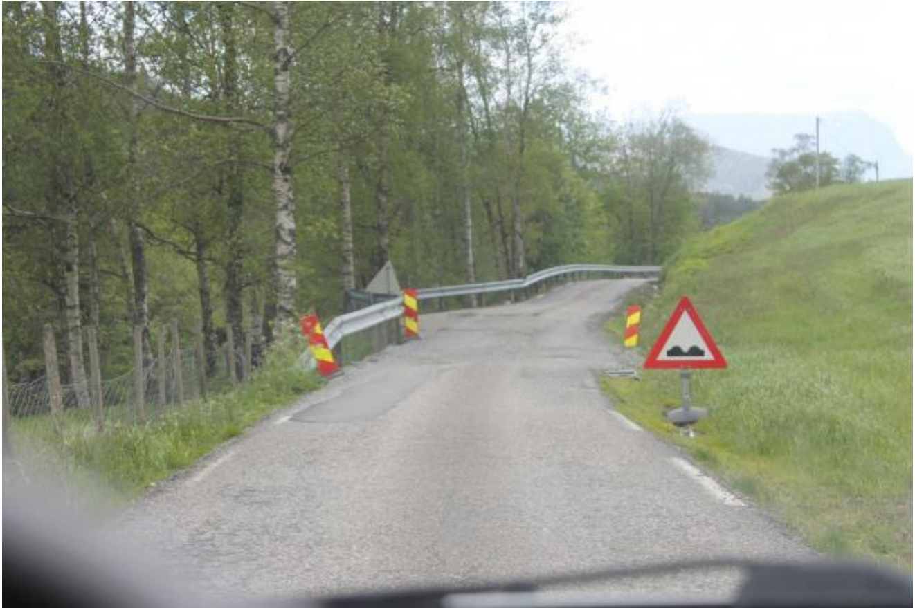
Snart kjem ny asfalt på denne strekningen
