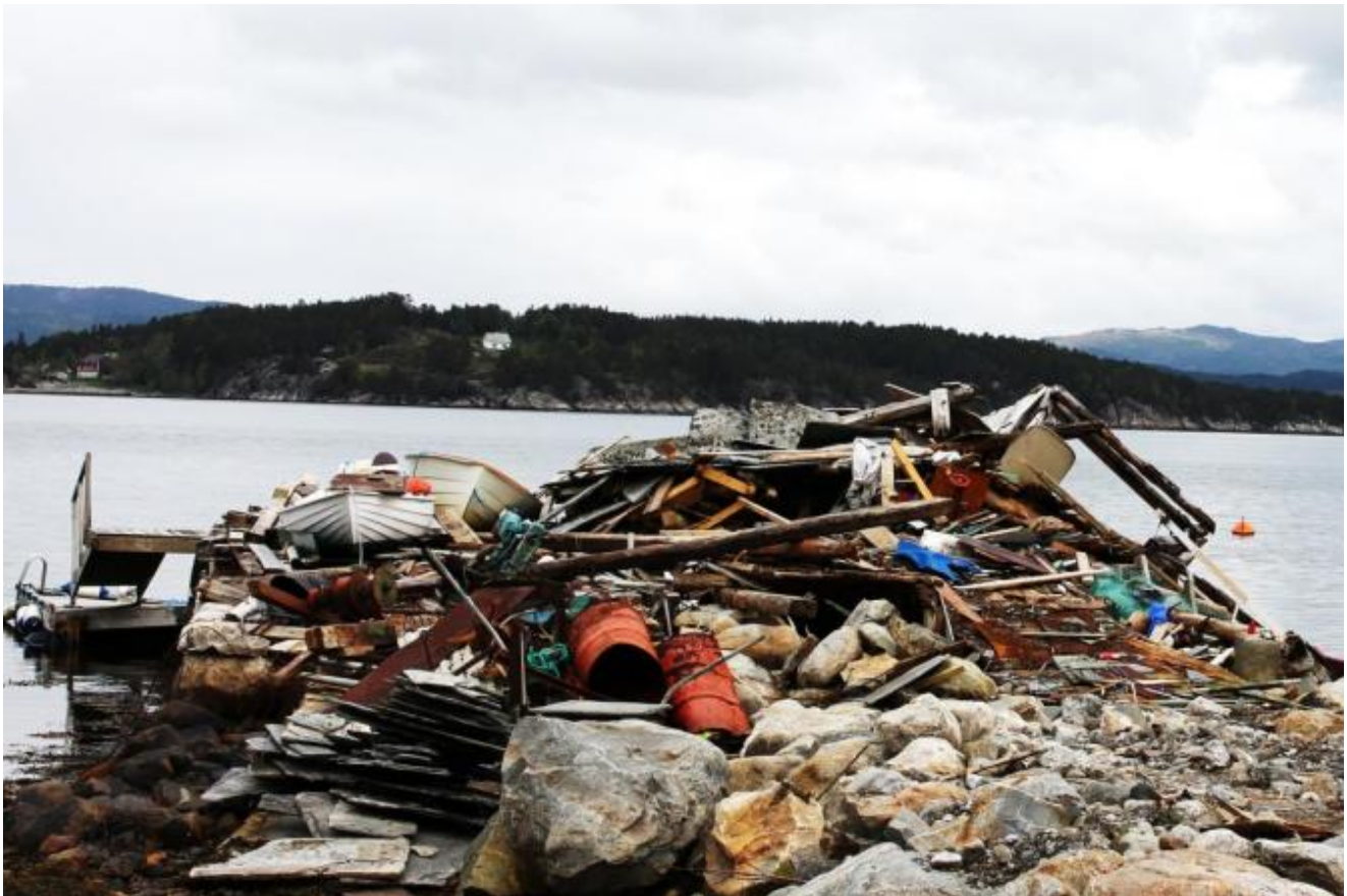
Raseringen av Sjøhuset var den største enkeltskaden i vår bygd. No er oppryddinga igang og så skal det reisast eit nytt og noko mindre hus.
