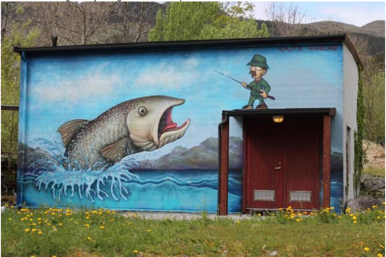
Den andre sida av kraftverket
