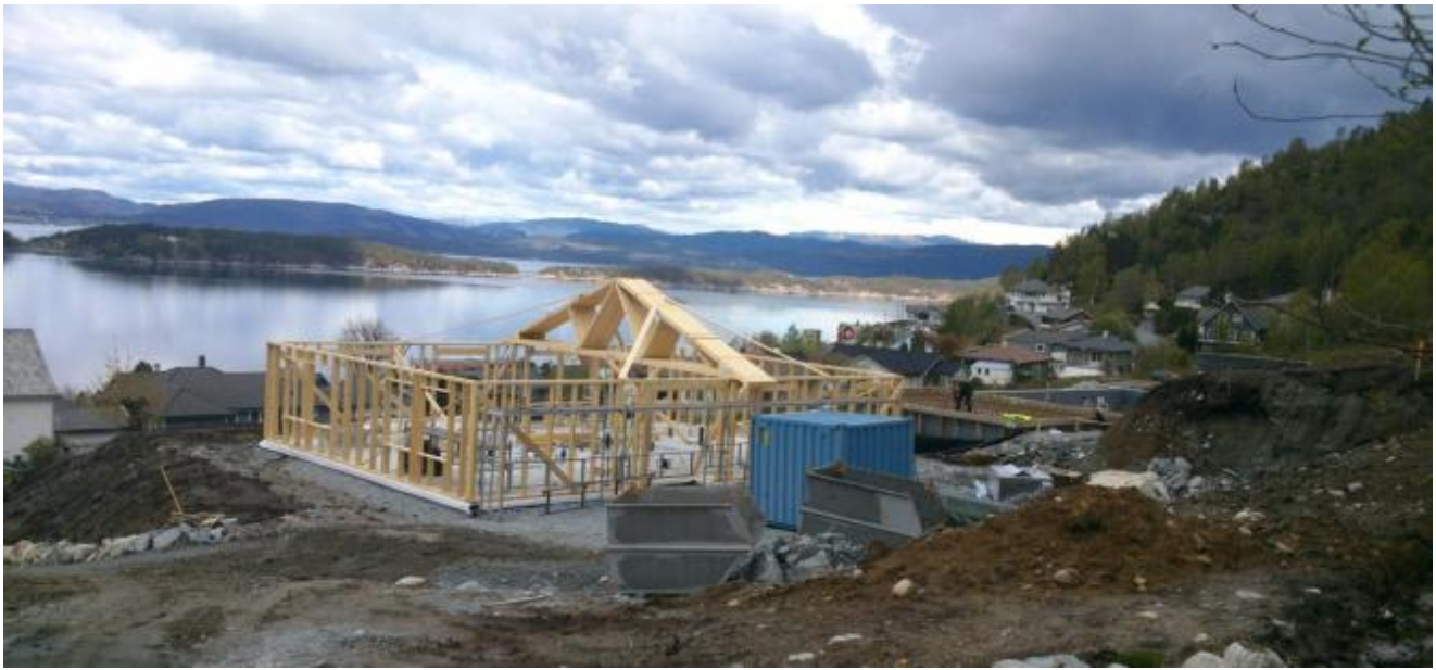
Byggjearbeid i gang og takstolar på plass. Utsikten vert nydeleg!
