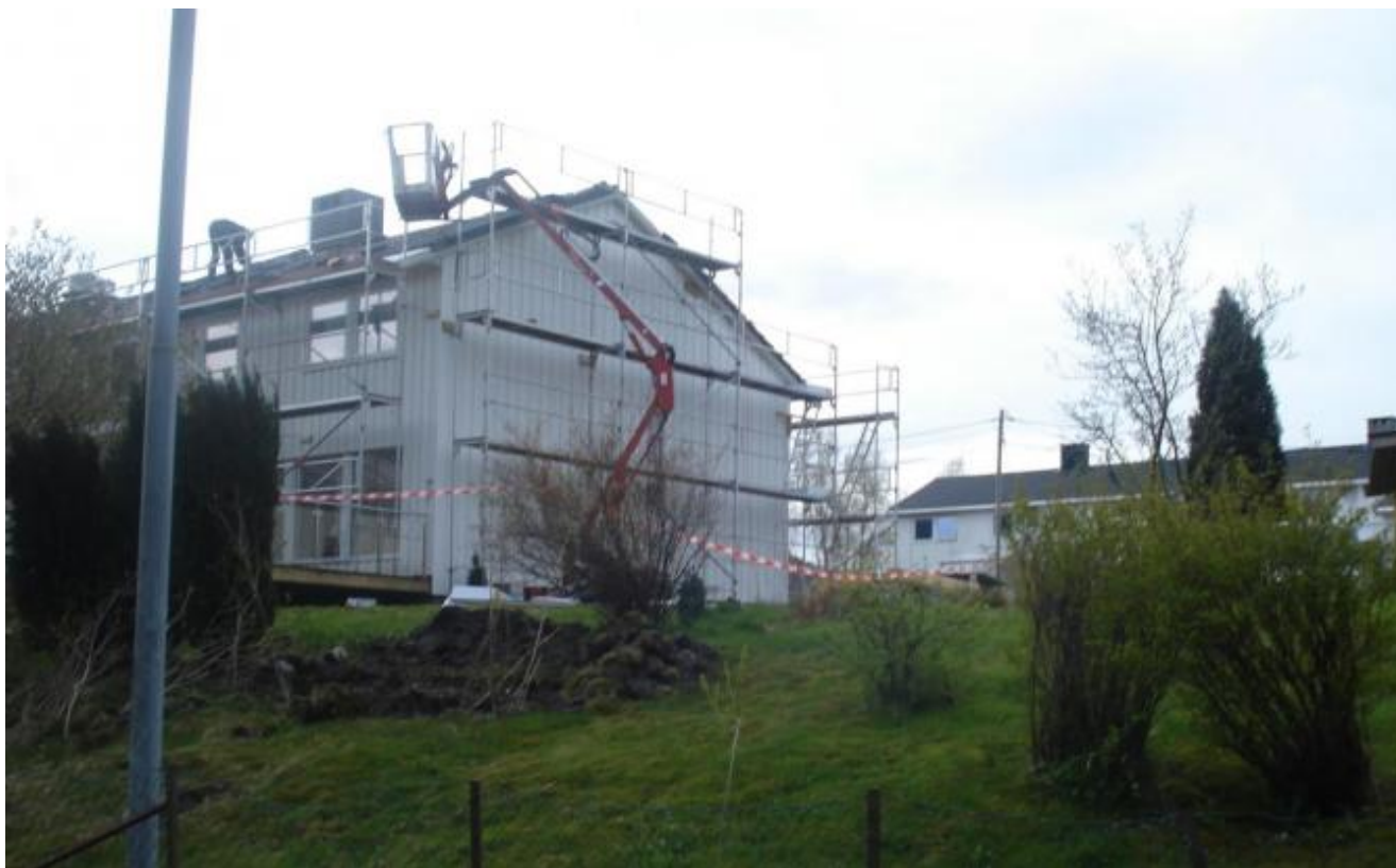
Byggmester Stensletten i arbeid med skifting av tak på Husnes
