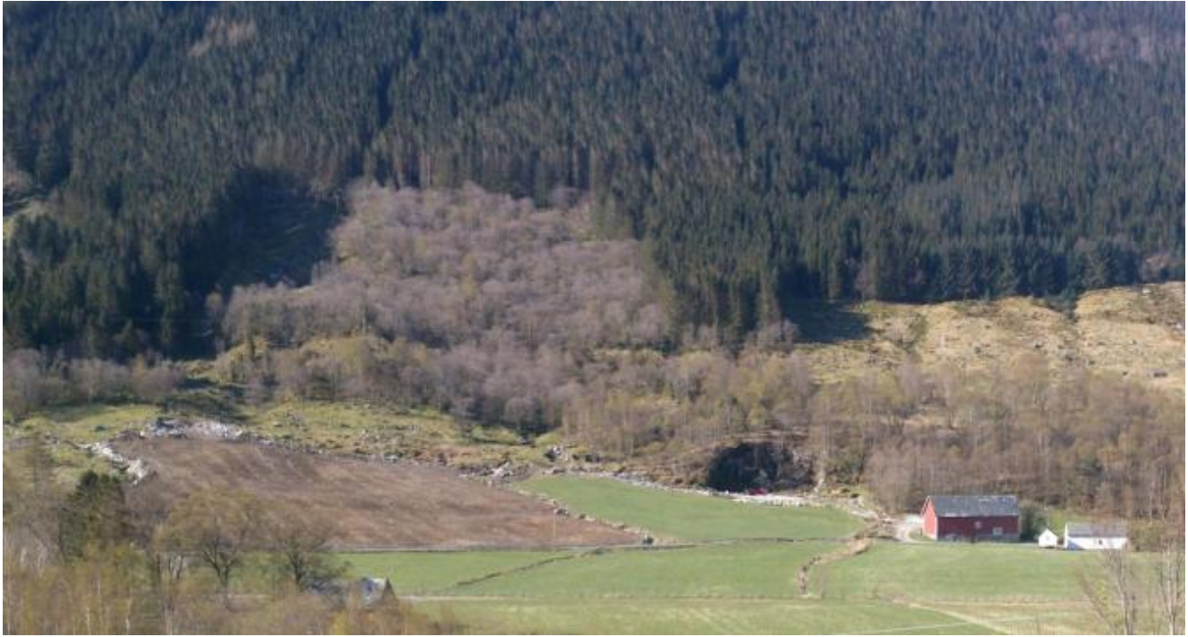
Eit imponerende nydyrkingsarbeid.
