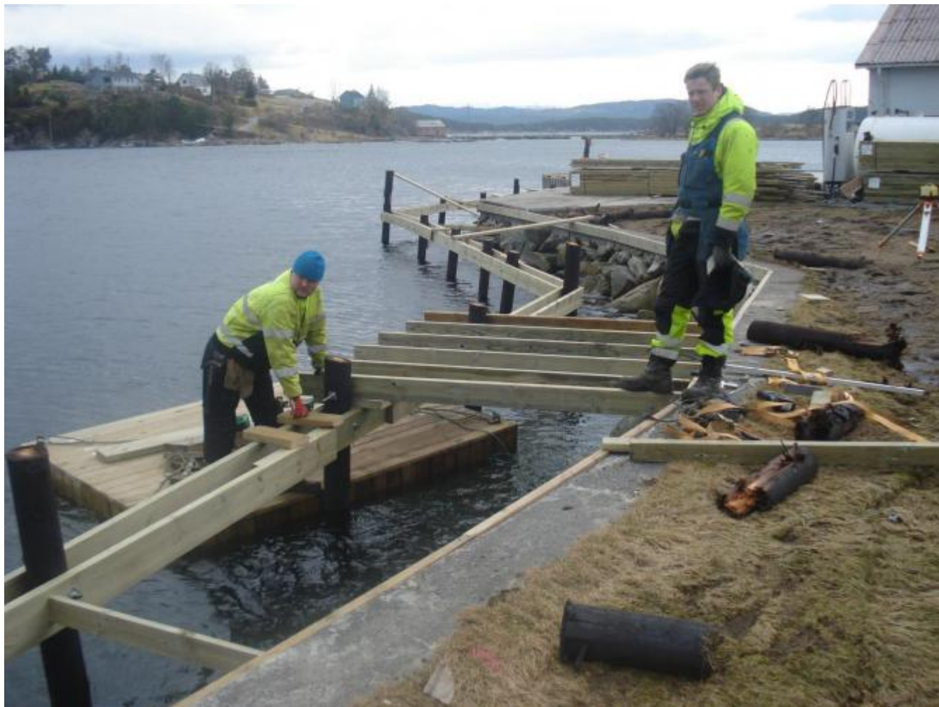
Arbeidet med kaien er starta.
