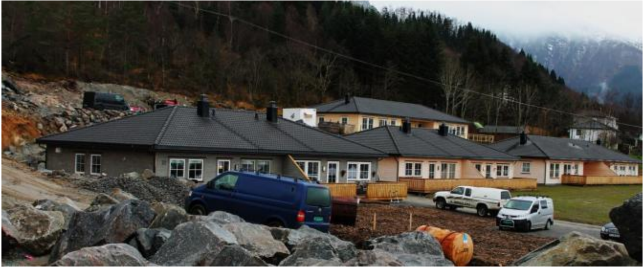
Byggjeverksemda var særleg aktiv i Ospelunden, som har plass for 65 tomtar. Dette biletet vart teke på haustparten.
