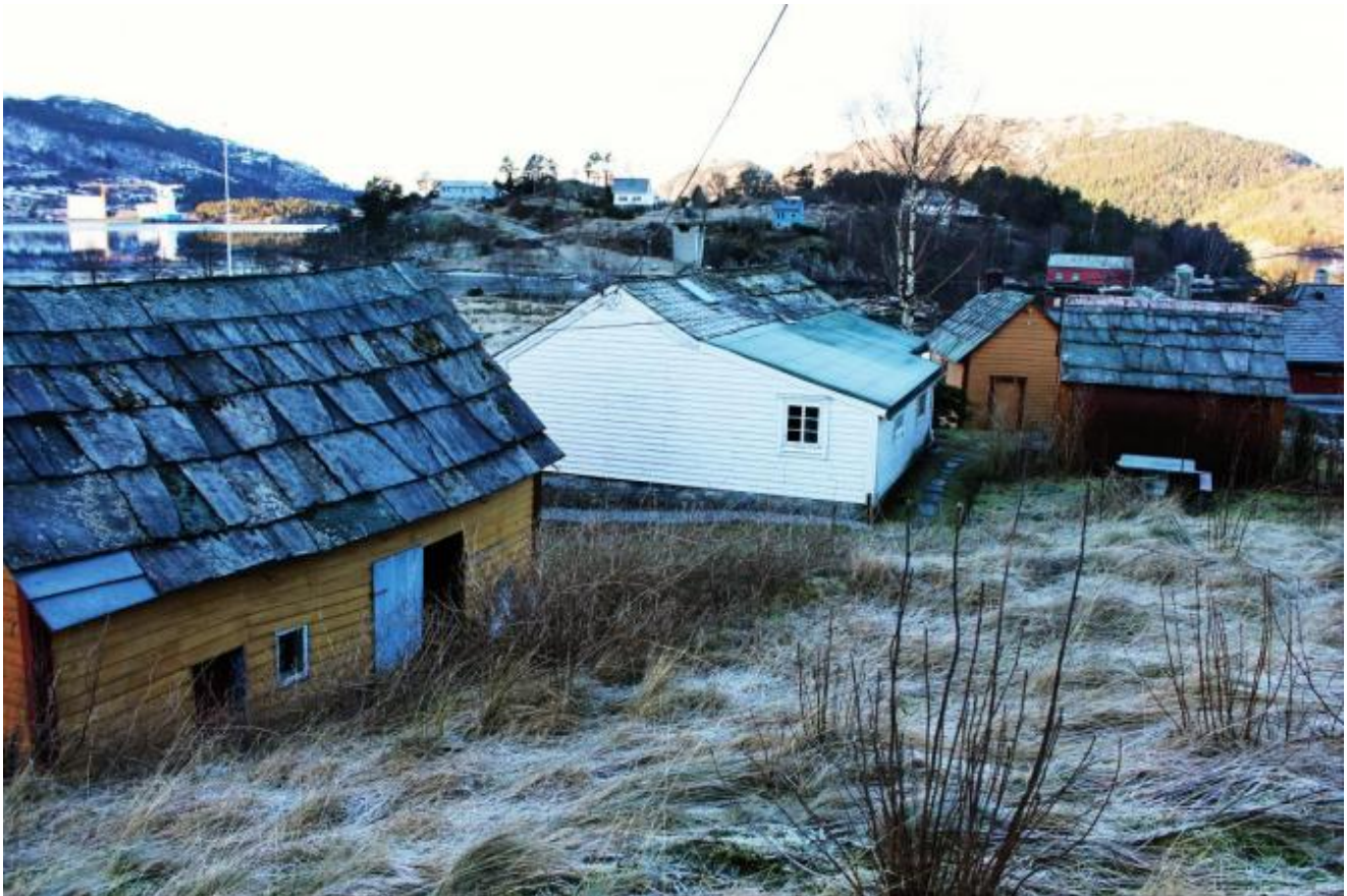
På dette bildet kan ein sjå 4 av dei 5 husa som no er under restaurering
