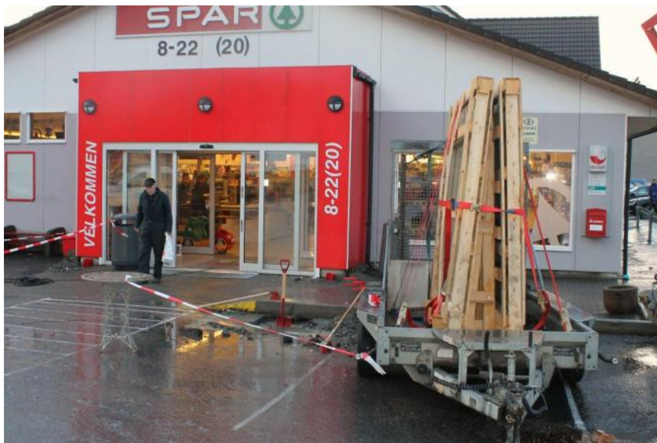
Arbeidet med glasoverbygget starta i dag
