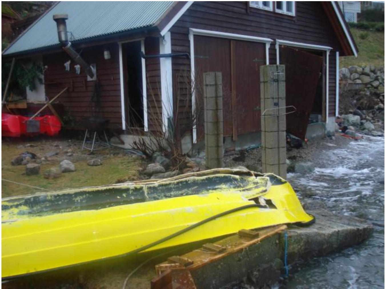
Stor skade på naust og båt i Kleivadalen
