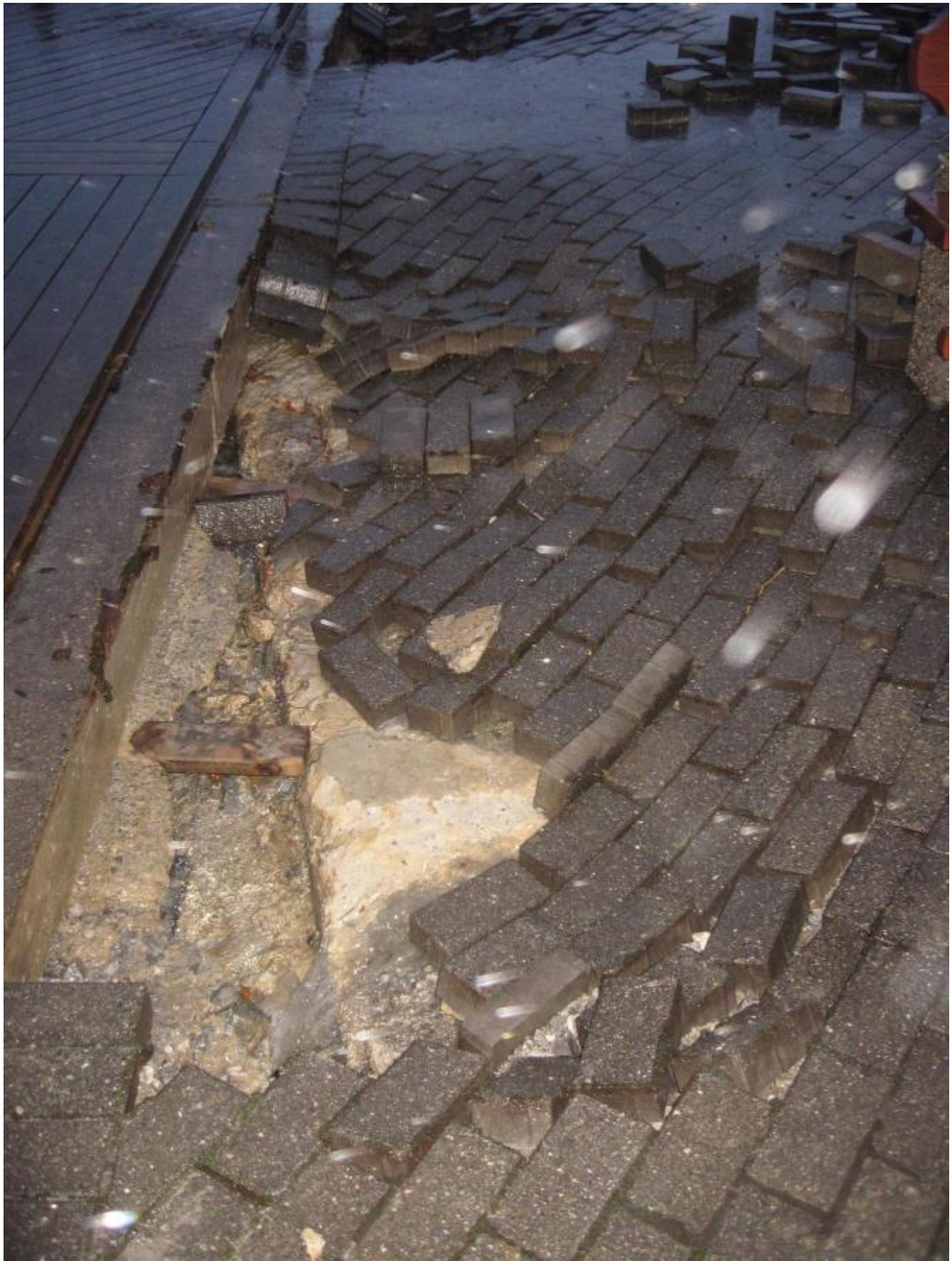
Høg flo og sterk pålandsvind gjer skade på kai/brustein i Beinavikjo(Foto: K. O. Bringedal)
