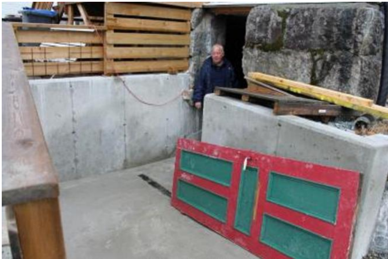
Uskedal Utvikling er godt i gang med arbeidet i kjellaren i Gamleskulen.
