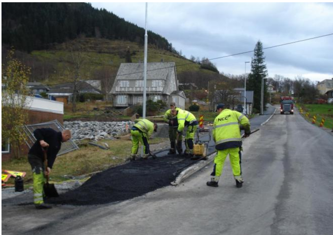
Arbeidet med asfalteringa er i ferd med å verte fullført i føremiddag.
